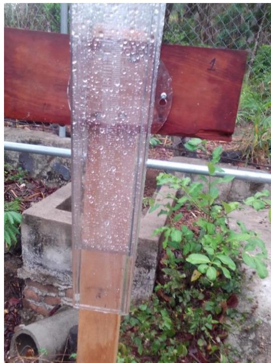
Figura 2.4. Instalación de pluviómetro para mediciones de precipitación en sitio.
