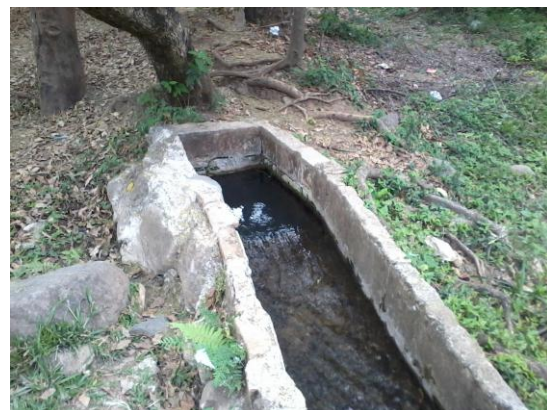
Imagen 20: Brote de agua freática.
