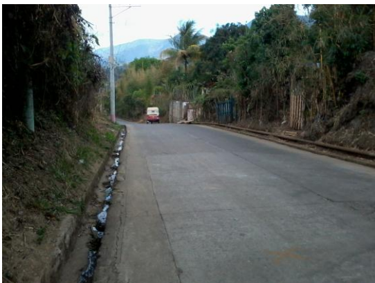
Imagen 25: Canaletas para la evacuación de aguas grises.
