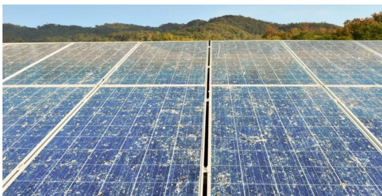
Ilustración 9. Acumulación de suciedad en paneles solares. Fuente: Delfos Energy
