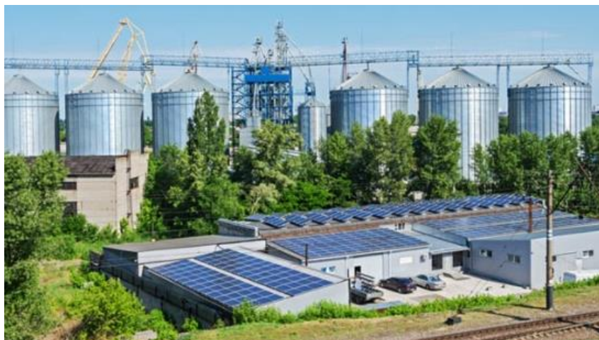
Ilustración 11. integración de paneles solares en la industria. Fuente: ColdWell Solar
