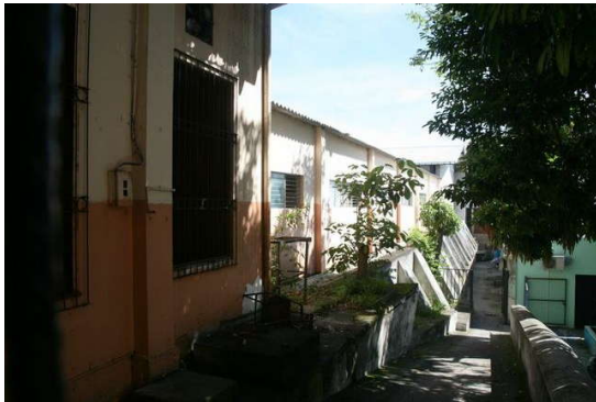
Img. 46 Contrafuertes y paredes de ladrillo
