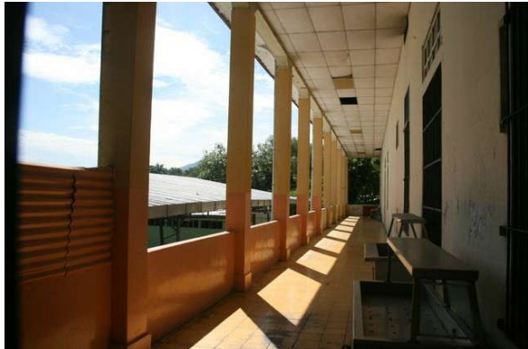
Img.55 Sistema de Marcos Estructurales en área de cocina
