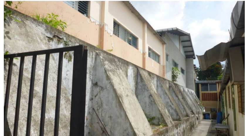
Img. 56 Vista este del edificio
