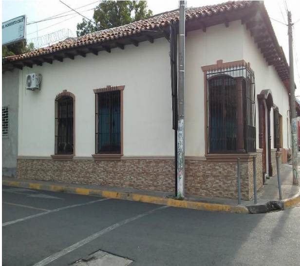
Casa de Adobe: Fotografía 16
