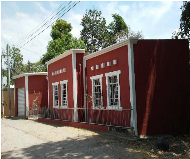
Casa de Bloque de Concreto Fotografía 18
