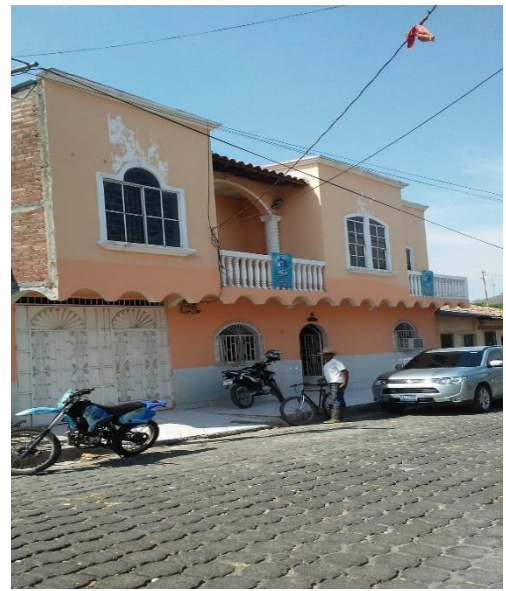
Casa de Ladrillo de Obra Fotografía 17
