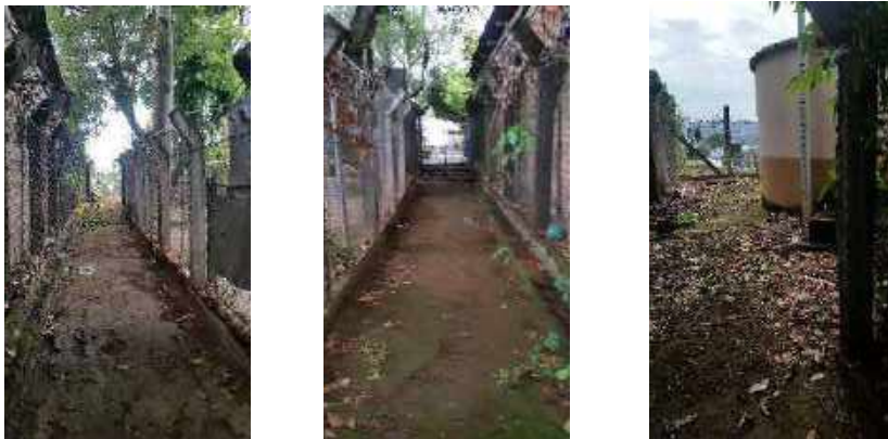
FOTO 14,15,16: Condiciones de Entrada sobre la parte posterior de Parque Central
