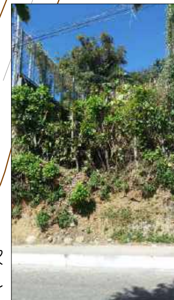
ACCESO #2 PRINCIPAL AL TERRENO DEL TALLER VOCACIONAL SOBRE LA 2da Av. Norte
