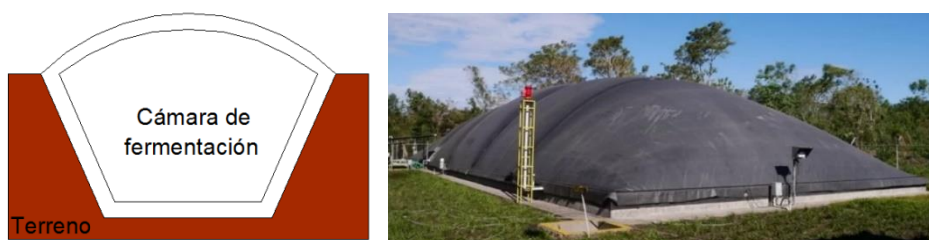
Figura 20. Biodigestor con geomembrana.
