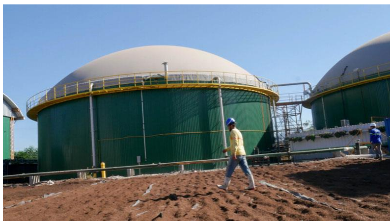
Figura 8. Dos enormes biodigestores procesan anualmente alrededor de 40 000 toneladas de desechos orgánicos en Grupo Campestre, en El Salvador. (“Granjas avícolas salvadoreñas producen biogás y alivian conflictos socioambientales”, 2024)
