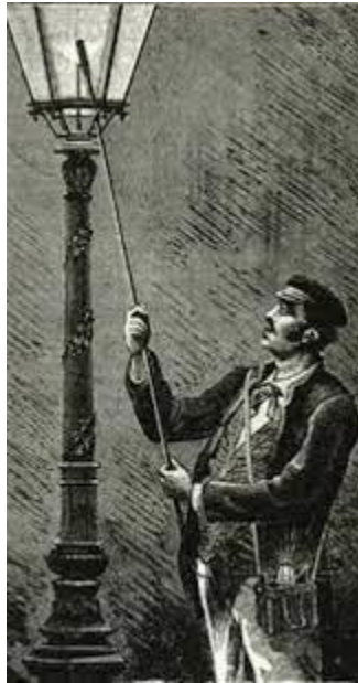
Figura 1. 1896 en Exeter, Inglaterra, las lámparas de alumbrado público eran alimentadas por el gas recolectado de los digestores que fermentaban los lodos cloacales de la ciudad
