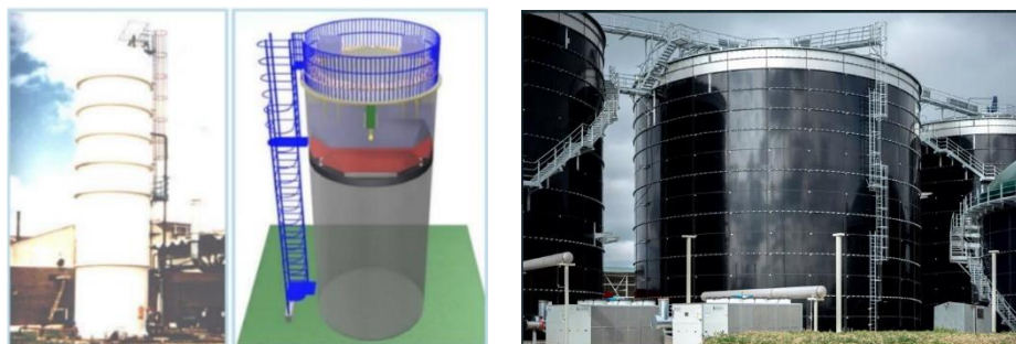
Figura 21. Biodigestor vertical prefabricado.
