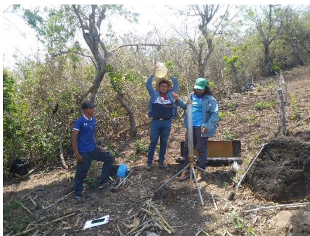
Figura 5. Ejecución de pruebas de infiltración, Cantón El Zapote, Nueva Concepción, marzo 2023
