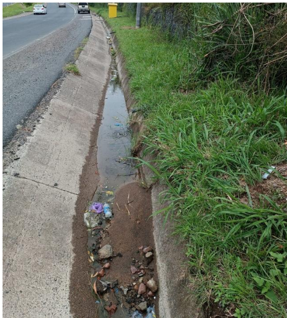
Figura 6-103. Se muestra acumulación de sedimentación que, por su aspecto, parece ser muy reciente. Fuente: Elaboración propia
