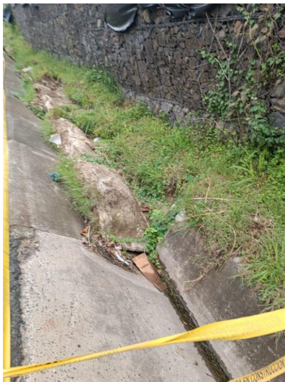
Figura 6-102. Se muestra sedimentación acumulada, la presencia de vegetación indica en ella indica que lleva varios días.
