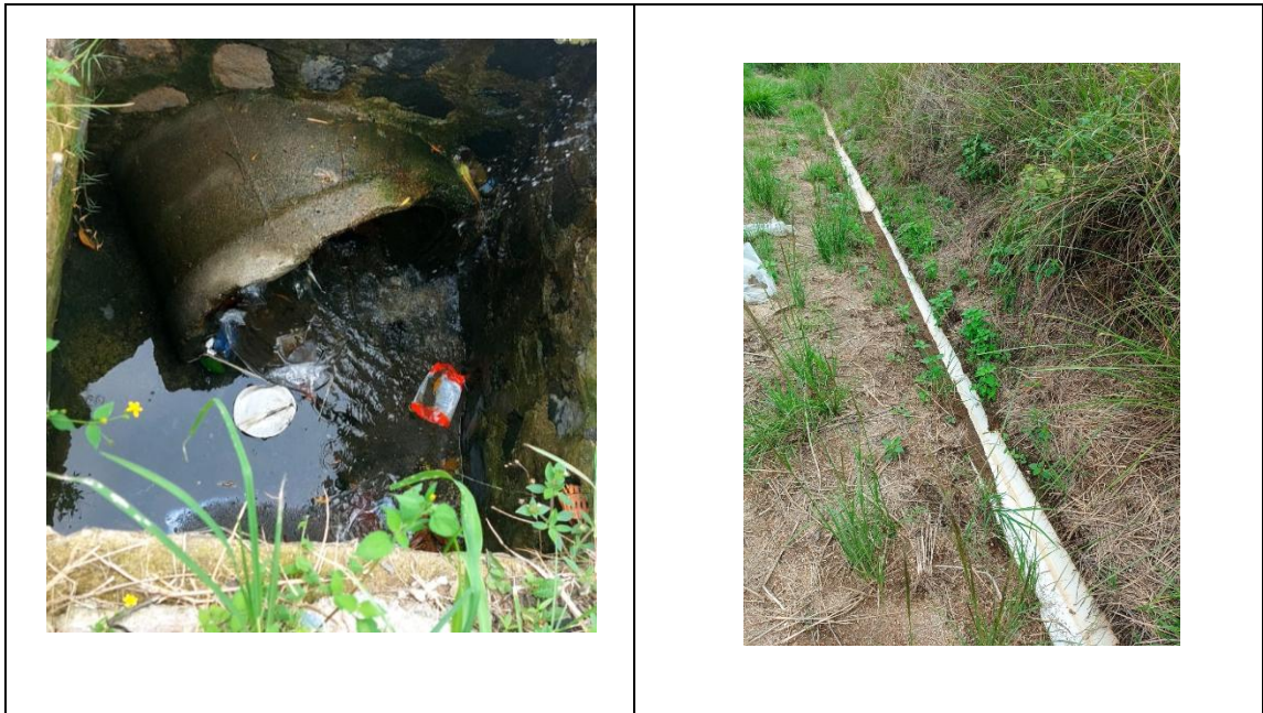
Figura 6-99. Se muestran elementos relacionados con la escorrentía pluvial del talud.
