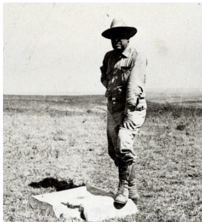
Figura 3-7. Estación fundamental del datum NAD27
