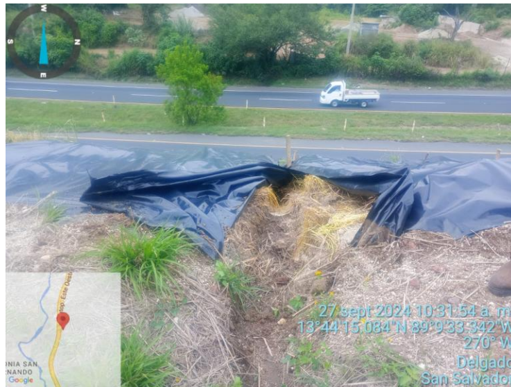
Figura 6-97. Se muestra recubrimiento de la parte baja del talud utilizando carpeta (plástico negro) y estacas de madera Fuente: Elaboración propia.
