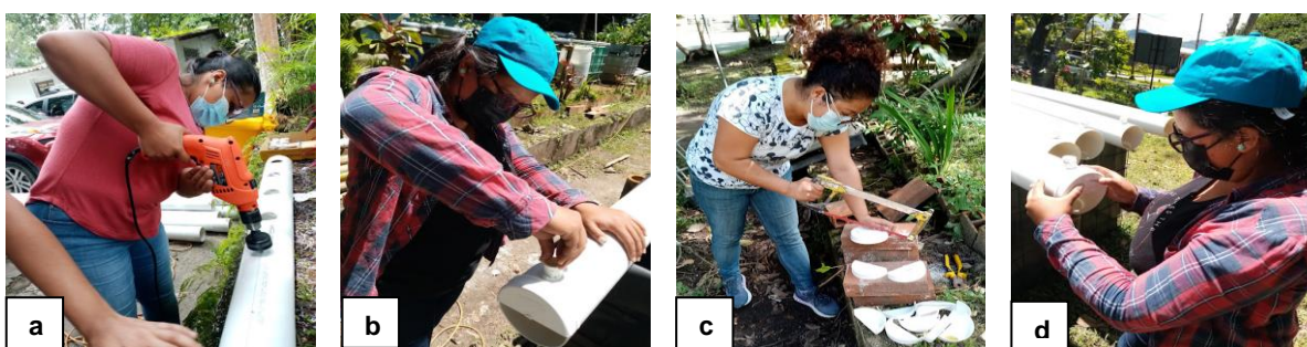
Figura 9. Ahoyado y colocación de adaptadores en tubos de PVC: a) perforación de tubos de PVC de 4 pulgadas; b) colocación de tapones machos al inicio y final del tubo; c) cortado de tapaderas de PVC; d) colocación de tapaderas de PVC.
