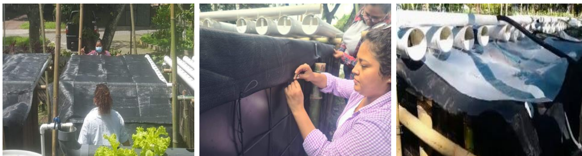
Figura 6. Colocación de malla sombra y plástico transparente sobre los estanques.
