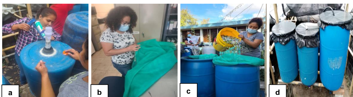
Figura 8. Construcción de los biofiltros: a) colocación y fijación de válvula de desagüe; b) elaboración de bolsa mosquitero; c) llenado de bolsas con material biofiltrante; d) tapado de barriles.
