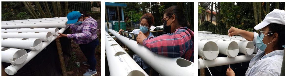
Figura 10. Colocación y nivelación de las camas de siembra sobre los estanques.
