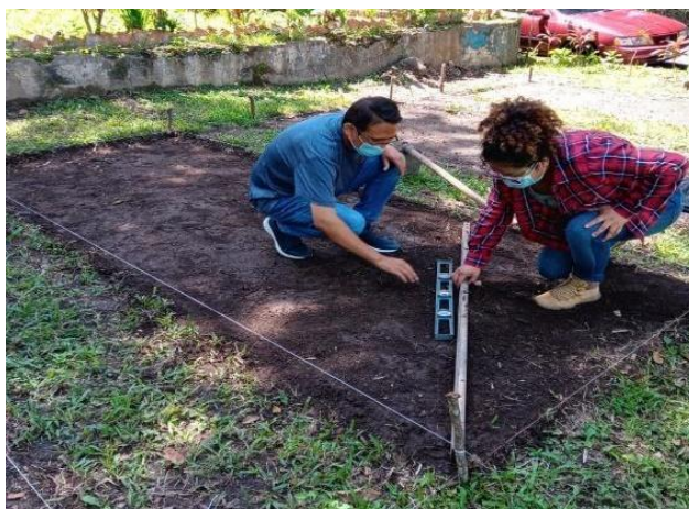
Figura 3. Delimitación y nivelación del área de cada sistema.
