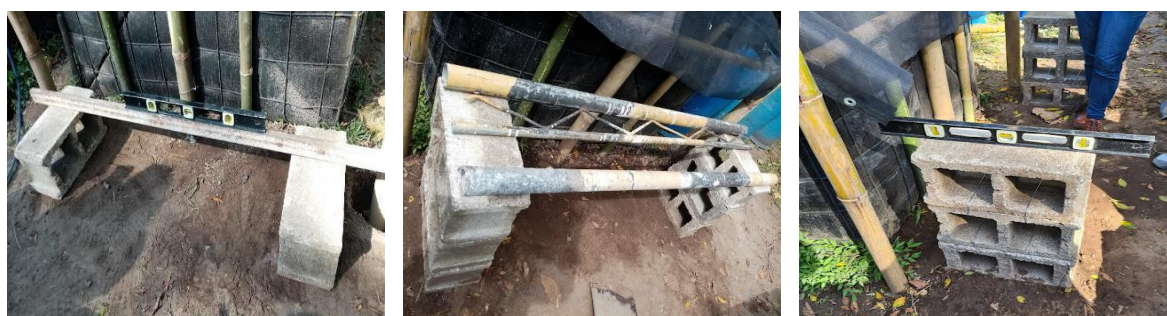
Figura 7. Construcción de bases para colocar los biofiltros.
