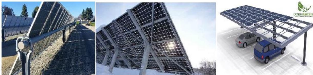
Figura 66. Estructura de soporte con marco para modulo bifacial.
