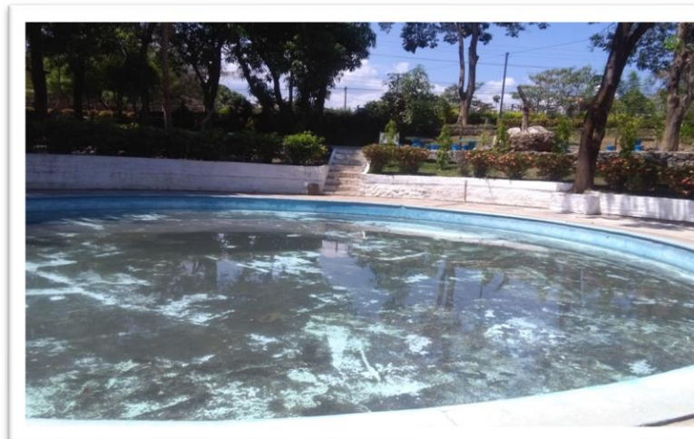
Fotografía 71. Piscina III. Fuente: fotografías recopiladas durante visitas técnicas.
