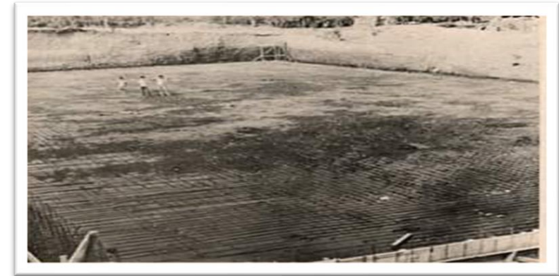
Fotografía 23. Aspecto de la piscina olímpica construida con el apoyo del pueblo en el balneario Altos de la Cueva en honor a Don Cristóbal de la Cueva entre 1968 y 1972. Recuperado de: Facebook, fotos de la publicación de Marvin Aguilar Umaña.
