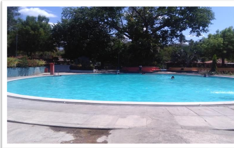
Fotografía 70. Piscina II. Fuente: fotografías recopiladas durante visitas técnicas.
