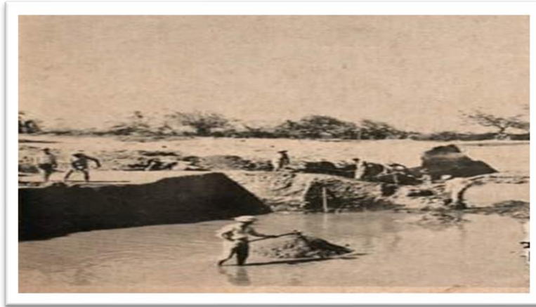
Fotografía 22. Trabajos de terracería en la piscina del balneario Altos de la Cueva entre 1968-1972. Recuperado de: Facebook, fotos de la publicación de Marvin Aguilar Umaña.
