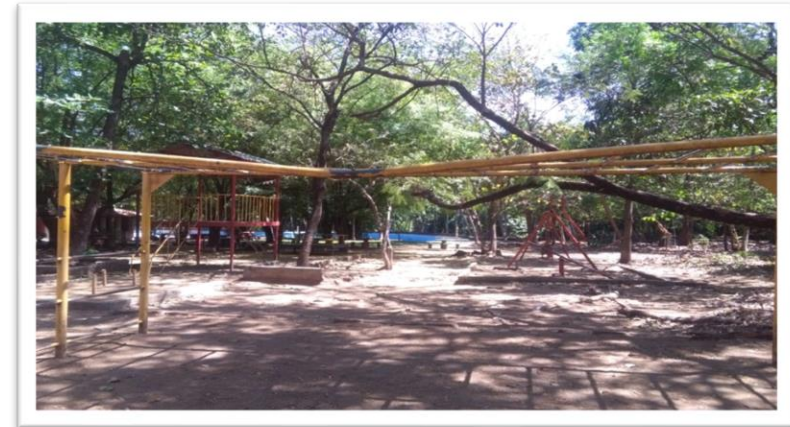
Fotografía 54. Juegos infantiles en muy mal estado. Fuente: fotografías recopiladas durante visitas técnicas.
