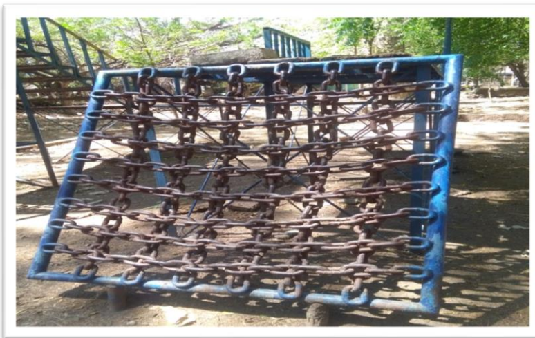
Fotografía 53. Juegos infantiles en muy mal estado. Fuente: fotografías recopiladas durante visitas técnicas.
