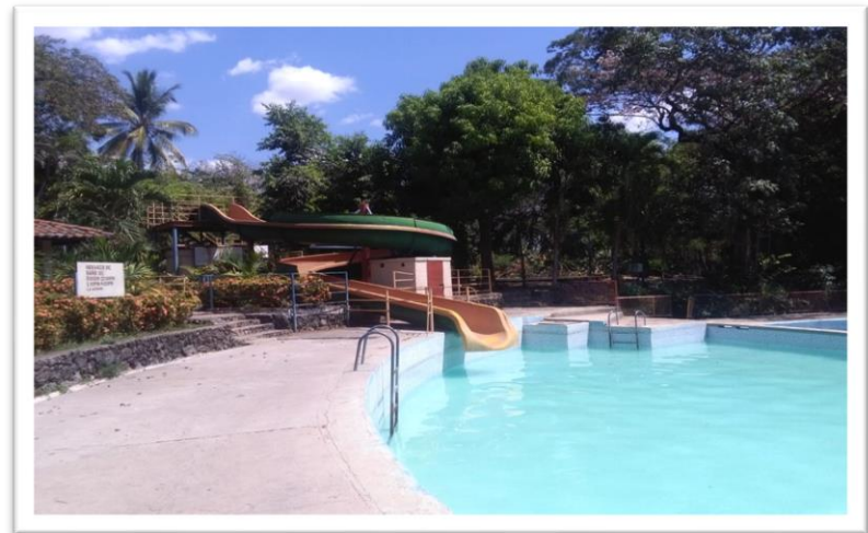
Fotografía 69. Piscina IV. Fuente: fotografías recopiladas durante visitas técnicas.
