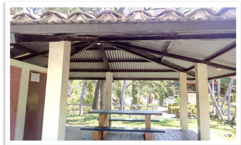
Fotografía 57. Kiosco-vestidor, se puede observar la estructura que sostiene el techo. Fuente: fotografías recopiladas durante visitas técnicas.
