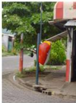
Telefono de TELECOM
