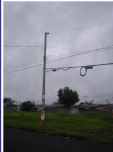
Posteado y tendido Eléctrico primario
