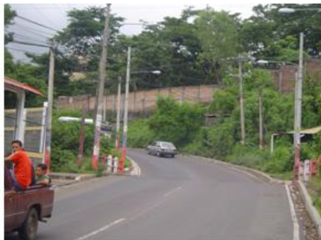
Fotografía: Acceso Principal: Prolongación 8ª. Calle Poniente. Pendientes pronunciadas en acceso a Urbanización. Favorecen la escorrentía superficial de las Aguas Lluvias
