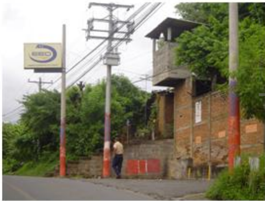
Fotografías: Sub-Estación de Empresa Eléctrica de Oriente, encargada Del suministro de energía eléctrica de la Urbanización Ciudad Pacífica.
