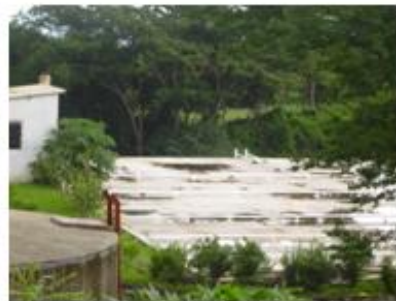
Planta de Tratamiento de Aguas Negras
