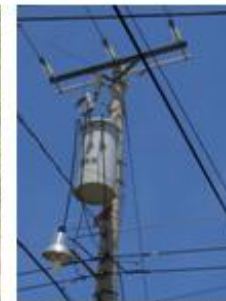
Luminarias en Postes
