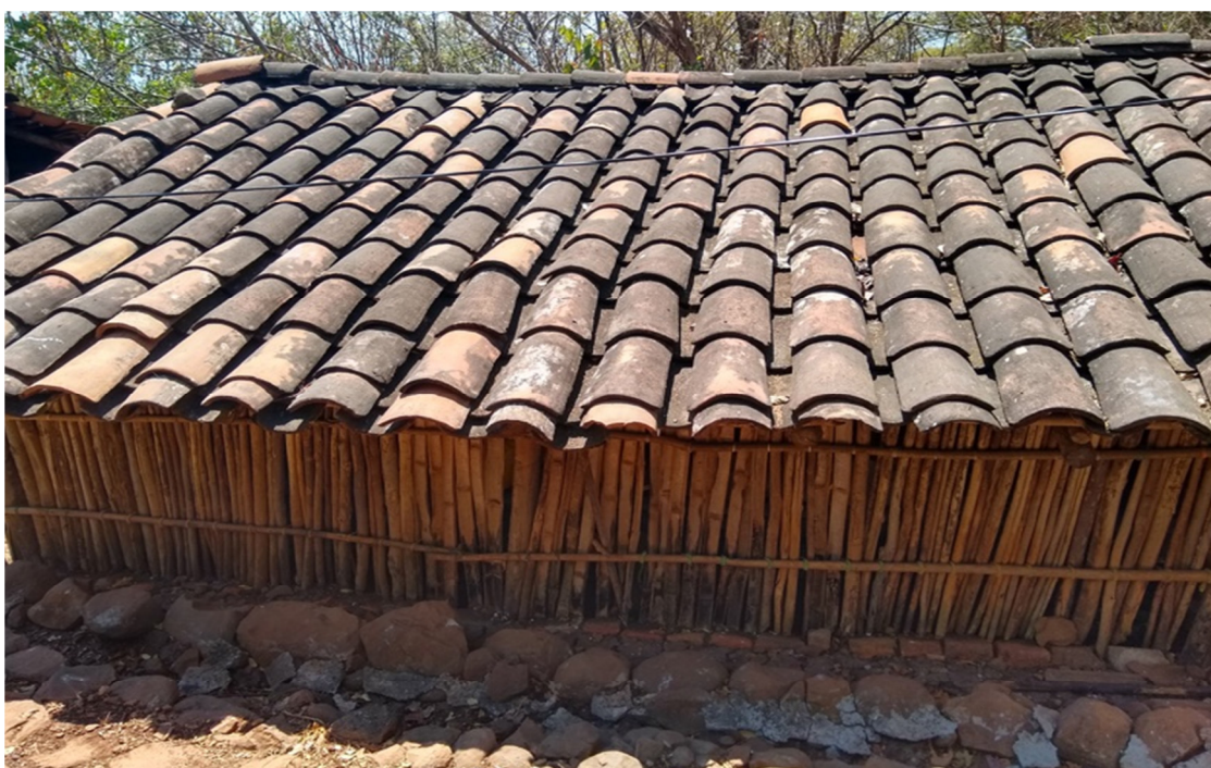
Figura 9.4: Tipo de techo y paredes de la vivienda que no cuenta con acceso a energía eléctrica.
