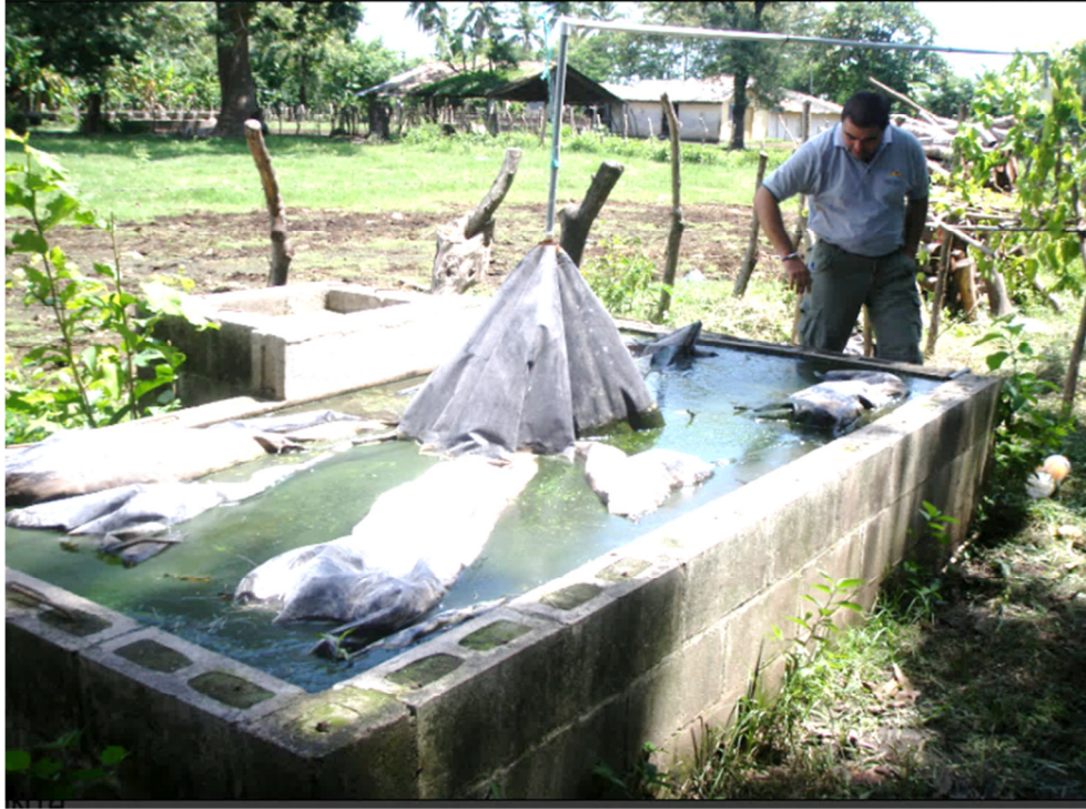
Figura 7.2: Biodigestor con el plástico cobertor dañado.
