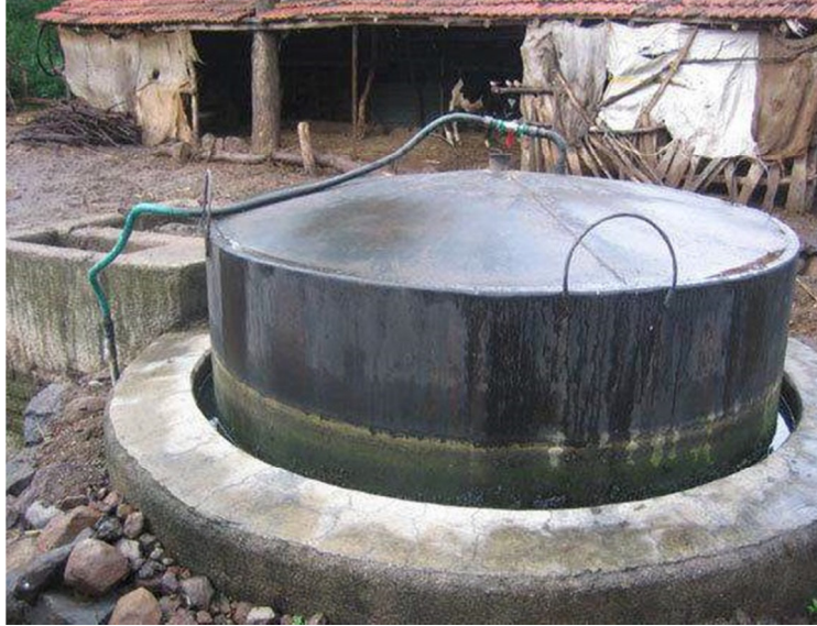
Figura 7.24: Planta de biogás con biodigestor tipo hindú.
