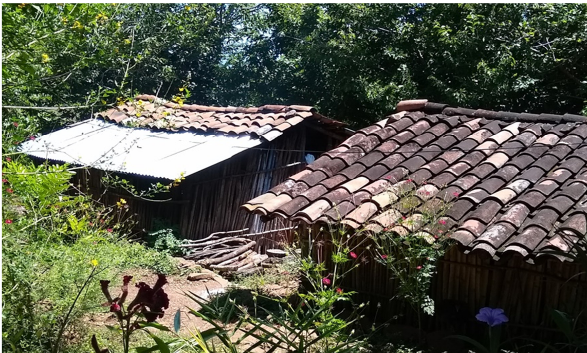
Figura 9.3: Vivienda identificado que no cuenta con energía eléctrica.
