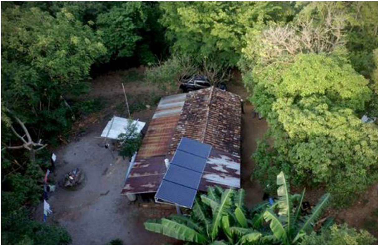
Figura 7.1: Instalación de un sistema fotovoltaico aislado en hogar rural.
