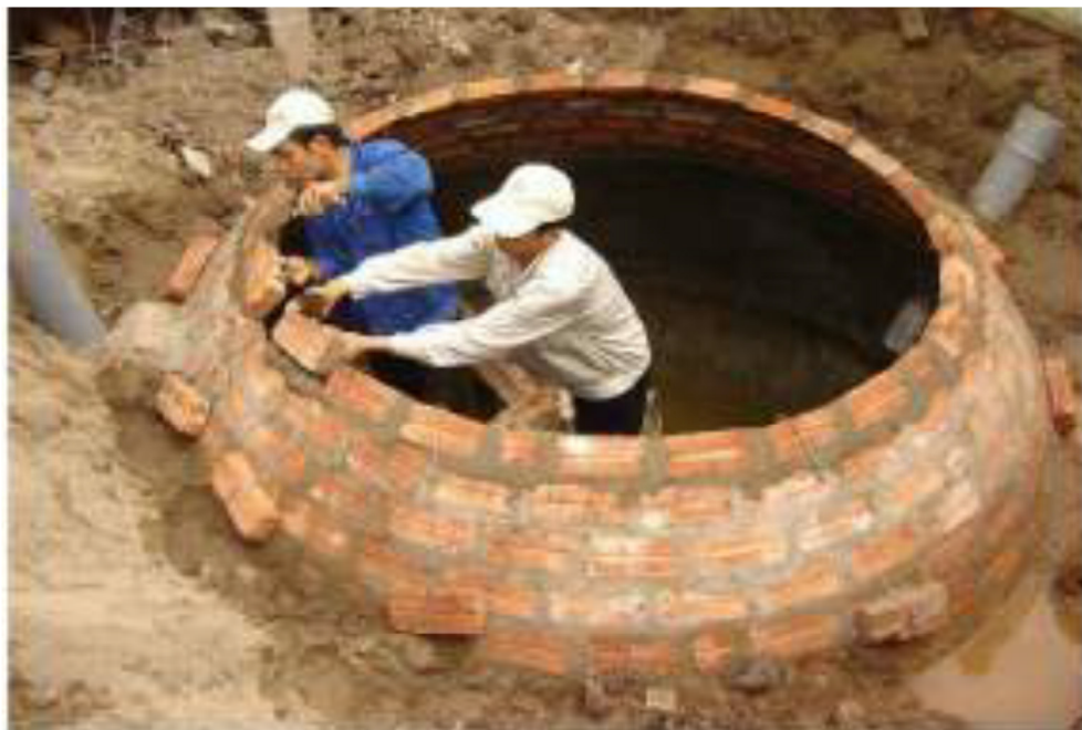
Figura 7.25: Construcción de biodigestor tipo chino en Vietnam.
