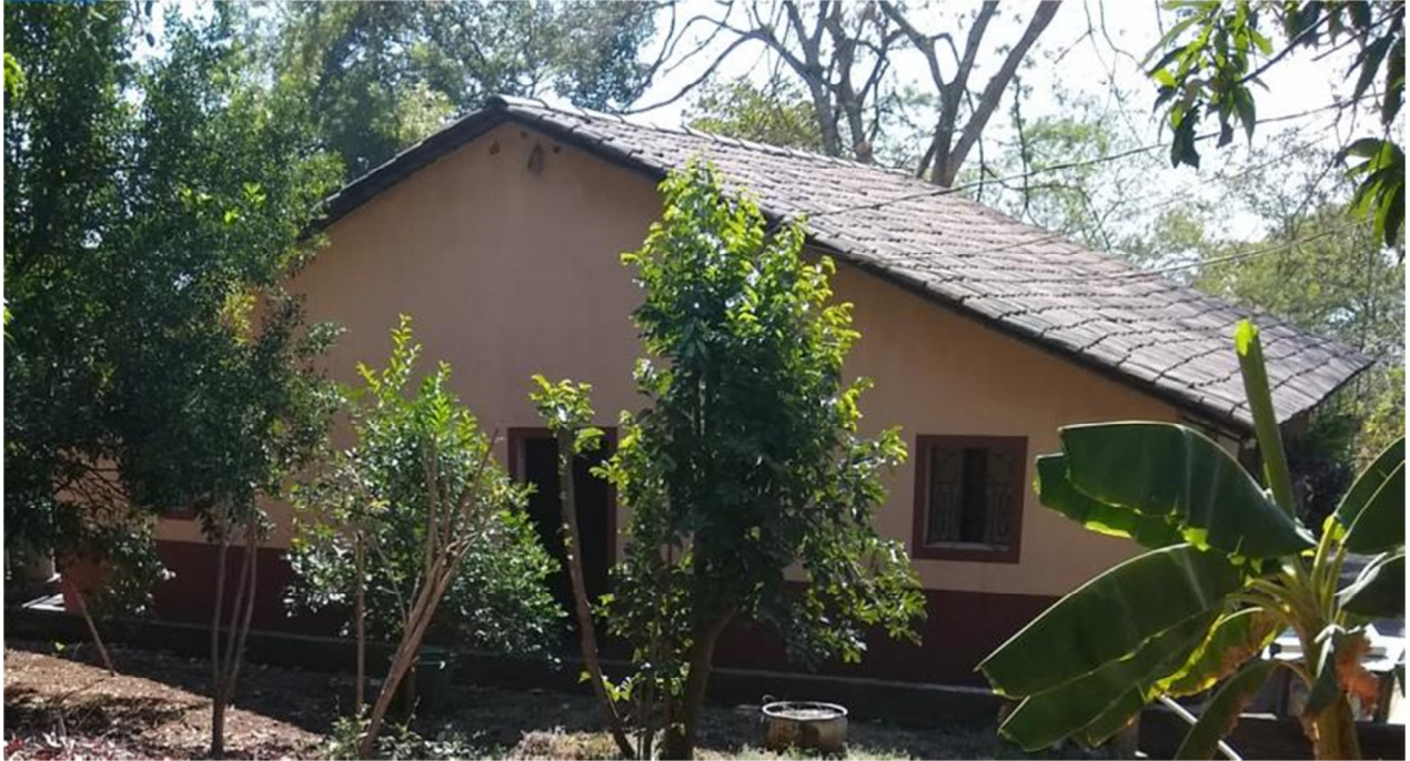
Figura 9.9: Infraestructura de la vivienda que cuenta con potencial para la generación de biogás.
