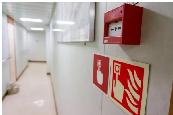
Ilustración 33 Señales Débiles Sistema de detección de Incendios
