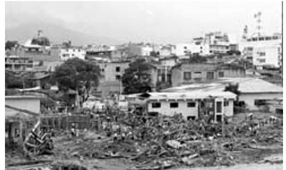
El huracán Fifi (1974), afectó severamente la infraestructura vial y productiva del país.
