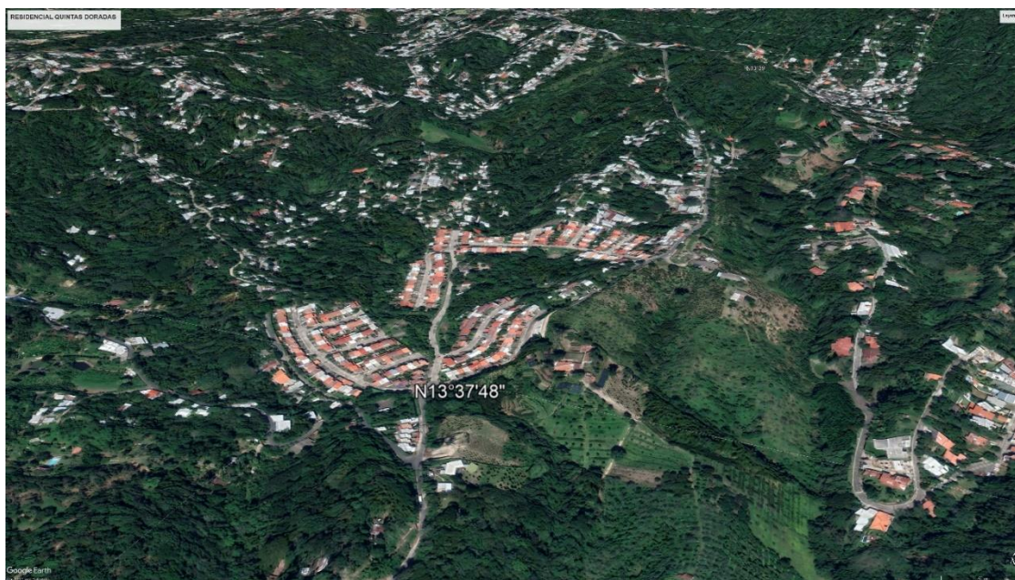
Ilustración 7. Vista aérea de la zona del talud Residencial “Quintas Doradas” municipio de Panchimalco (tomado de Google earth).
