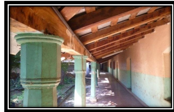
Fotografía Nº 7 Detalle de Columna de Madera.
