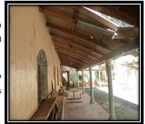
Fotografía N° 2 Daños en Estructura de Techo.
