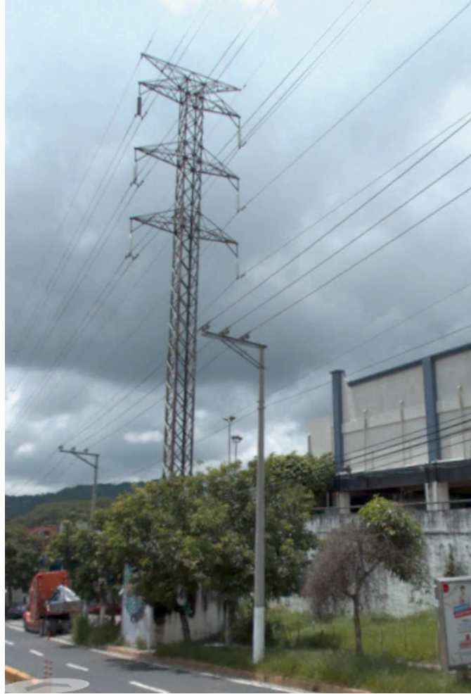
Figura 2.4 - Estructura Autosoportada del Sistema de Transmisión de El Salvador, 115kV, 2 circuitos. Ubicada en Santa Tecla, La Libertad Sur.
