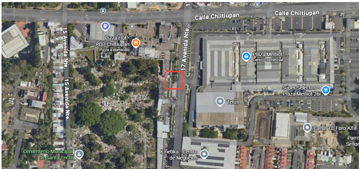
Figura 2.3 - Ubicación de Estructura Autoportada, 115kV
