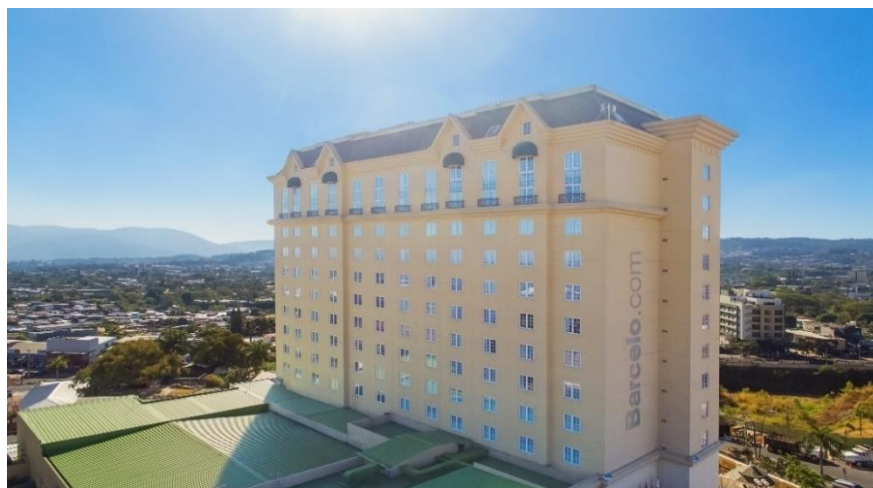
Figura 5: Instalaciones Hotel Barceló El Salvador
