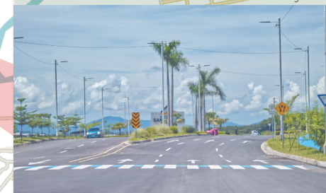
Foto 39: Final de 30 av. Sur Camino al Proyecto
