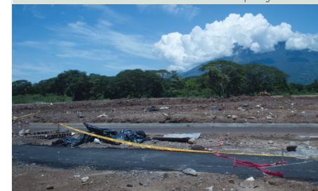
Foto 45: Vista vialidad hacia el proyecto
