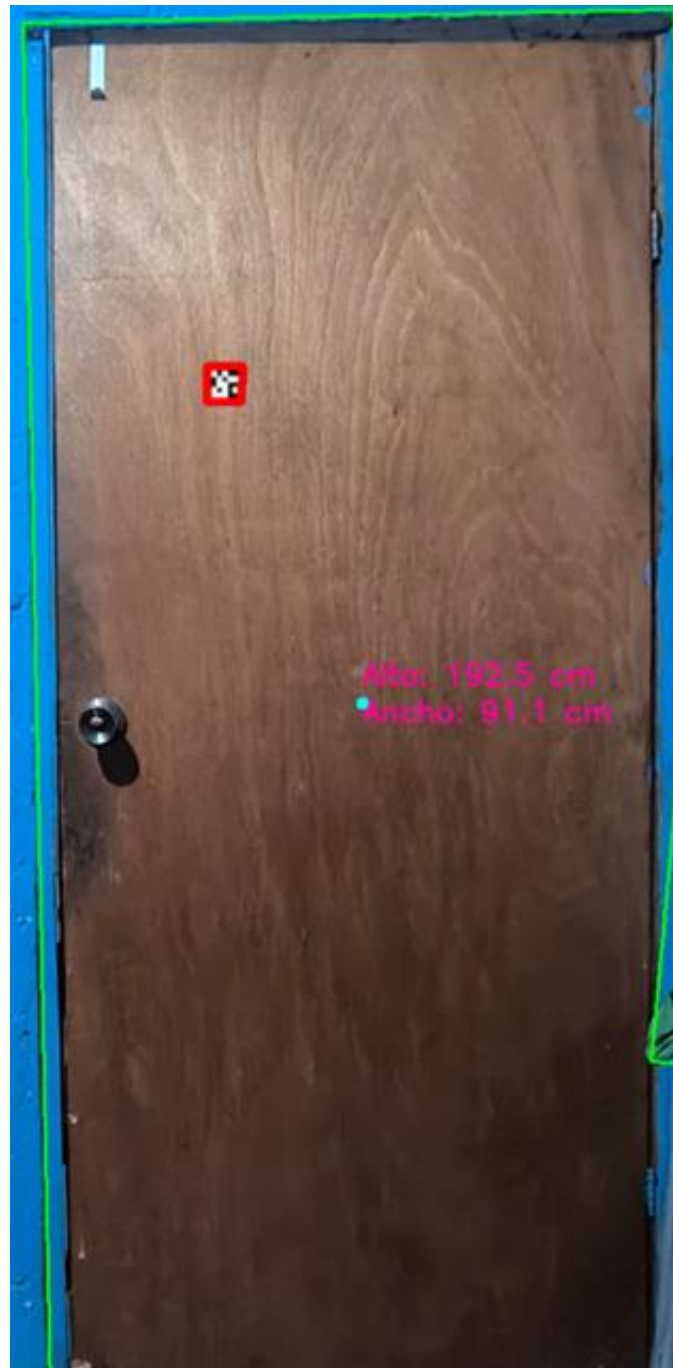
Figura 2: Se presenta la medida estimada de una puerta con el equipo, en rojo se muestra el marcador aruco, se obtuvo una altura de 1.92 metros. Fuente. Elaboración propia
