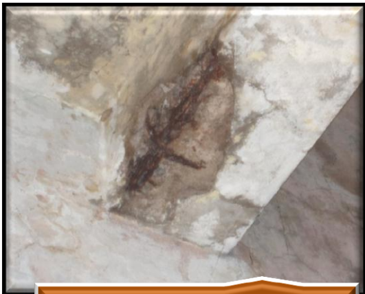
Fig. 50: Viga área de Taquilla
