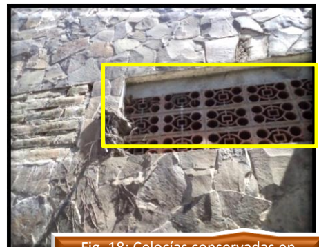
Fig. 18: Celosías conservadas en ventanas de fachada sur
