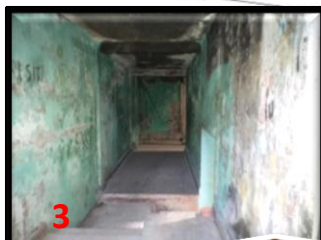
Fig. 27: Pasillo externo, ubicado en costado norte, Ex Cine
