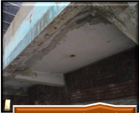
Fig.42: Mezzanine, ubicado en área superior Ex Cine Centenario
