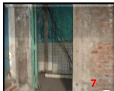
Fig.33: Baños ubicados en segundo nivel
