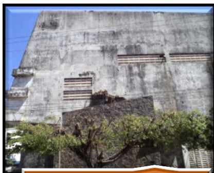
Fig.16: Fachada sur, Ex Cine Centenario, Usulután
