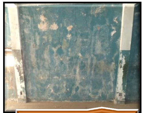
Fig. 56: Parte posterior de la Fachada
