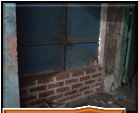
Fig.43: Puerta ubicada al costado sur, Ex Cine Centenario
