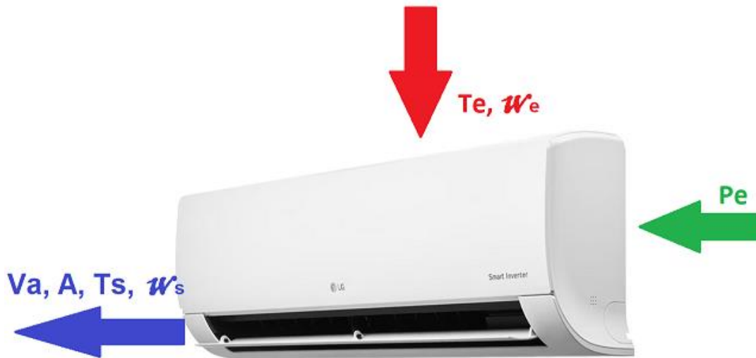
Figura 2: Esquema de las variables medidas para el cálculo del EER (Tecnológico de Monterrey).
