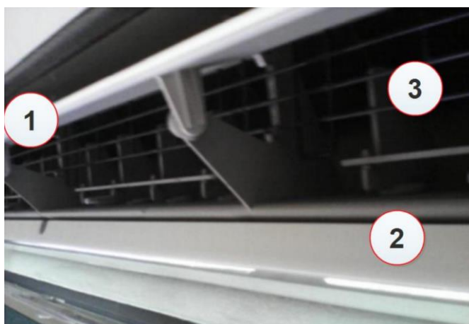
Figura 3: Posición correcta de difusores para la medición
