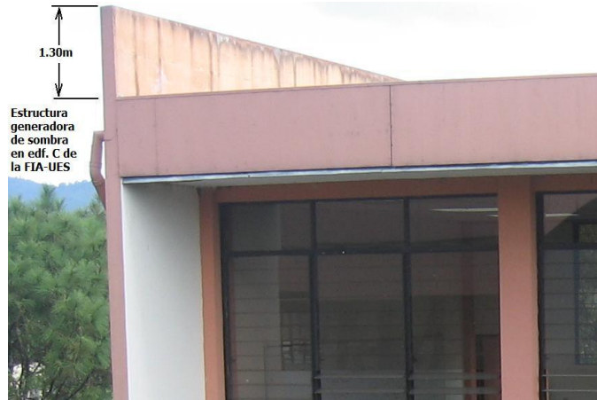
Fig.2.35. Estructura Generadora de sombra en el edificio “C” de la FIA-UES
