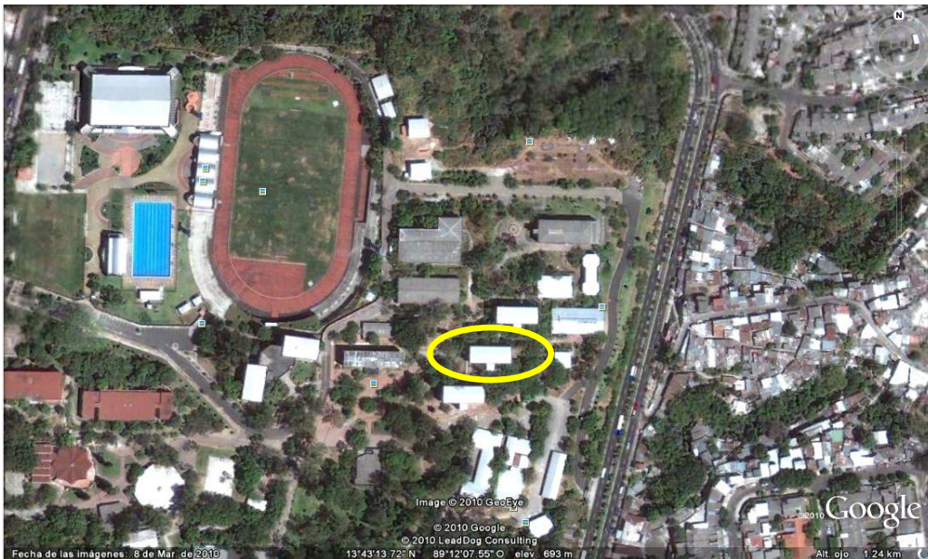
Fig. 2.34. Ubicación del Edificio “C” de Aulas FIA-UES.
