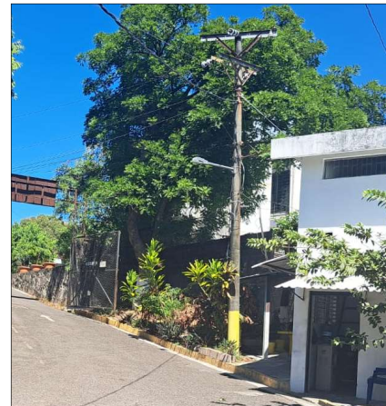
Foto N° 36: Poste de energía eléctrica
