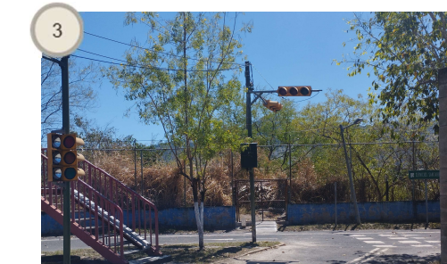
Foto N°10: Vista a Estación de camiones
