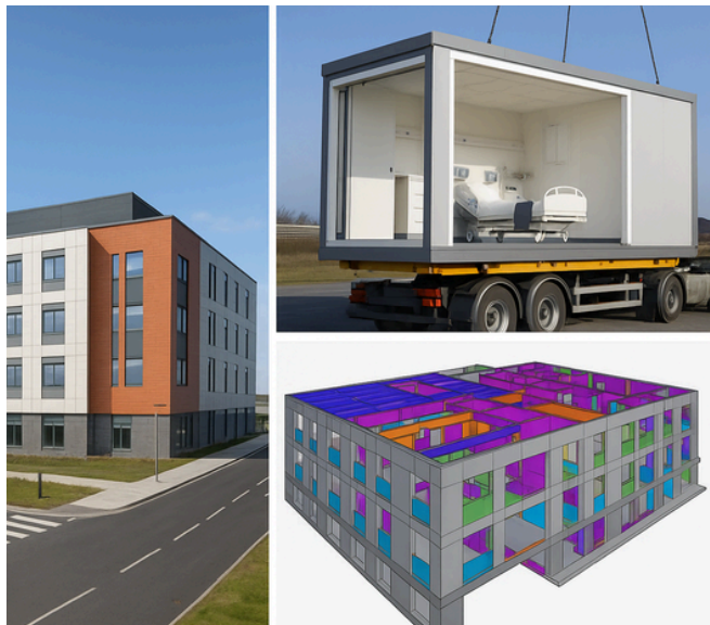
Figura 3. Construcción de Grange University Hospital (Reino Unido): BIM aplicado a prefabricados. Fuente: Autor
