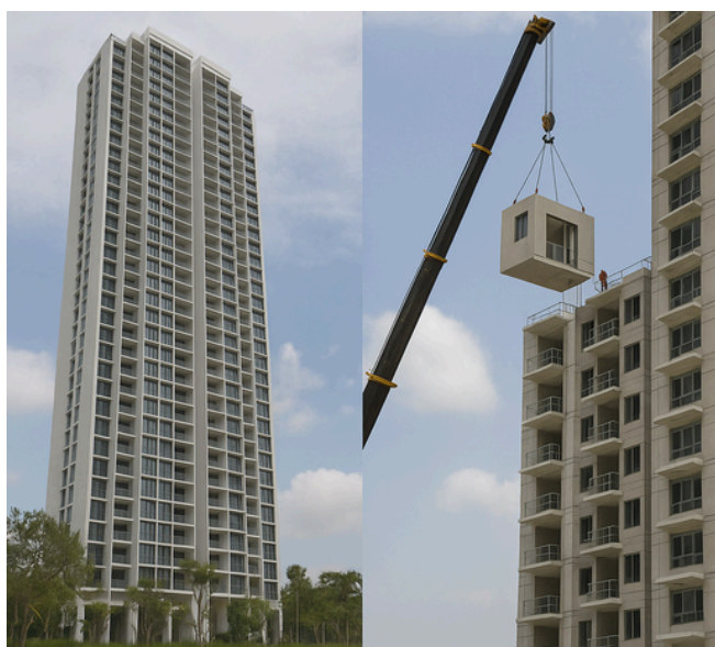
Figura 1. The Clement Canopy (Singapur) - PPVC y BIM para torres en concreto. Se produjeron e instalaron 1'866 módulos. Fuente: Recurso Digital, https://acortar.link/POnkgK
