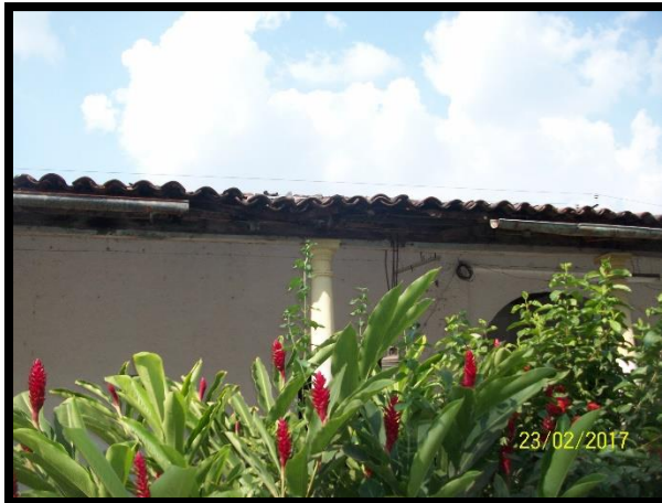
Ilustración 22 CANALES EXISTENTES DEL PÓRTICO DE LA ZONA ADMINISTRATIVA DEL CEMENTERIO
