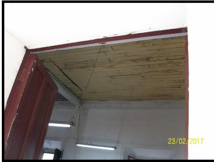
Ilustración 28 CIELO FALSO ORIGINAL CONSERVADO EN UNA ZONA DE LA ADMINISTRACIÓN
