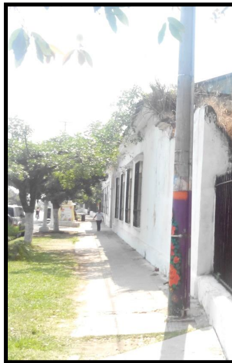
Ilustración 43 VISTA DE LADO OESTE FACHADA DE LA ADMINISTRACION
