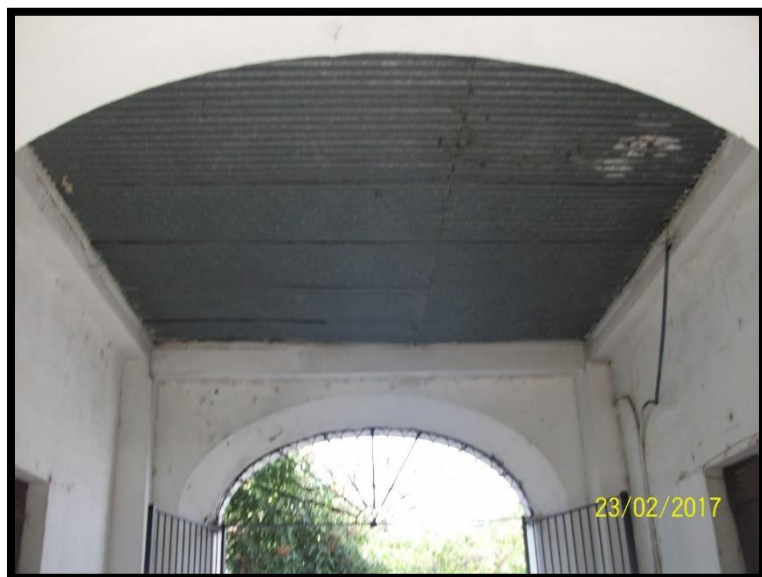
Ilustración 31 CIELO FALSO DE LÁMINA GALVANIZADA EN EL VESTÍBULO
