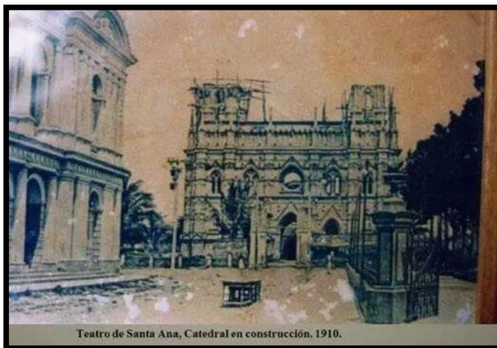
Ilustración 36 CONSTRUCCION DE CATEDRAL DE SANTA ANA 1910
