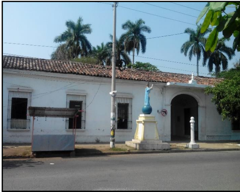
FACHADA NORTE DE LA ADMINISTRACION DEL CEMENTERIO
