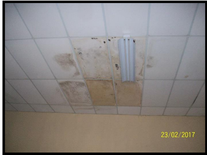
Ilustración 21 CIELO FALSO DE LA CAPILLA
