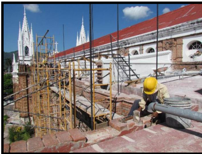
Ilustración 37 TRABAJOS DE RESTAURACION EN PAREDES SUR-ESTE DE LA CATEDRAL
