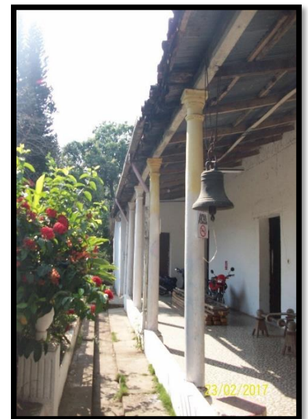
Ilustración 13 COLUMNAS INTERNAS VISTA OESTE
