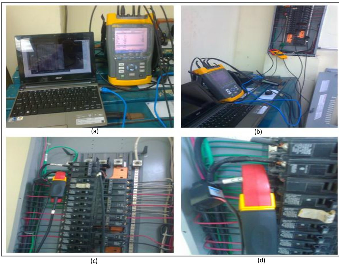
Figura D.7: (a) Analizar de carga FLUK; (b) Conexión del analizador a un tablero eléctrico; (c) Tablero eléctrico; (d) Conexión de las pinza del medidor y el analizador FLUK en la misma fase.
