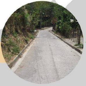
Calle El Progreso. Vía que constituye uno de los bordes del área urbana.
