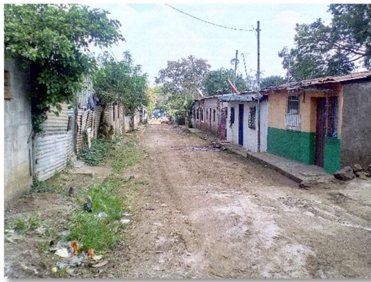
Ilustración 56: Tendido Eléctrico existente
