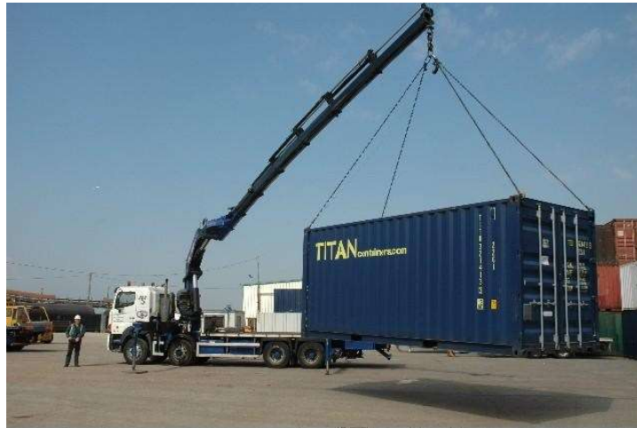
Ilustración 86 y 87. Montaje y desmontaje de contenedor
