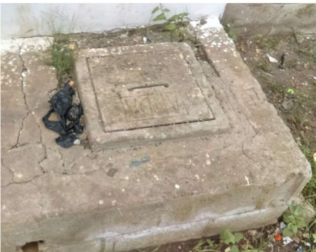
Ilustración 61: calle principal, colonia Emanuel, contador de agua potable Fuente: Elaboración propia
