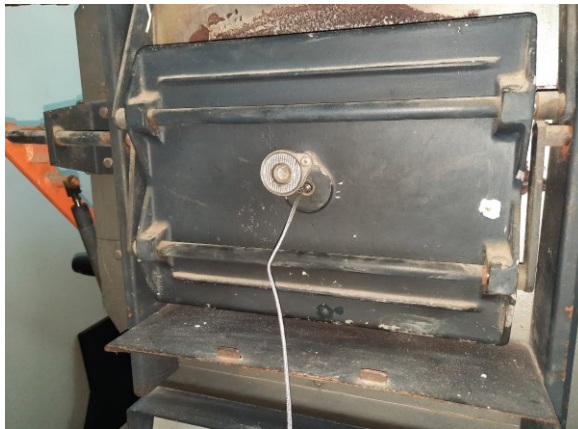
Ilustración 67 Termopar insertado en mirilla de horno de tratamientos térmicos.
