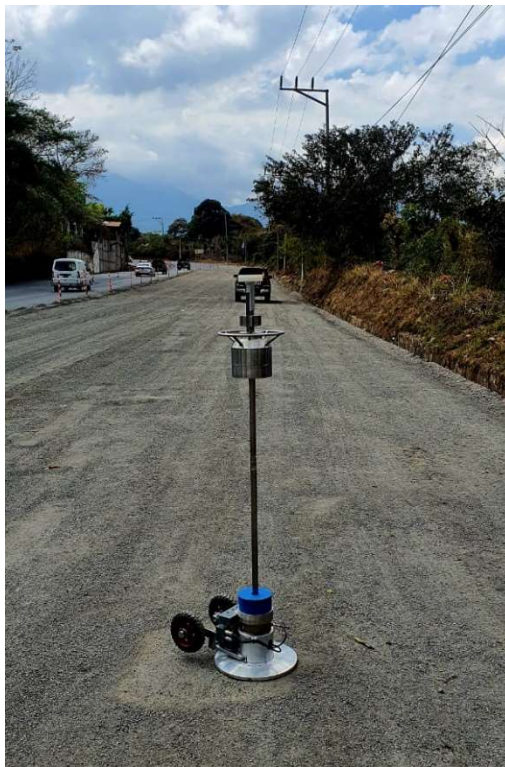
Figura 5.1.6.2-1 Ubicación de equipo y preparación de superficie.
