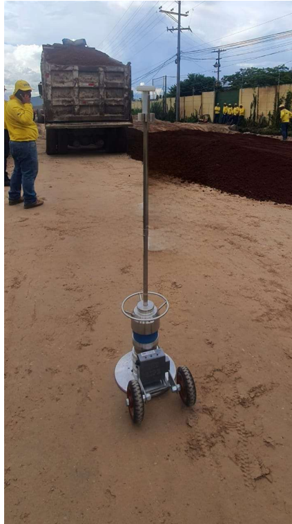
Figura 5.1.6.2-2 Medición de módulo previo a la conformación y compactación de siguiente capa.
