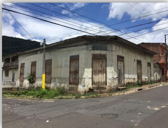
Imagen 21. Inmueble en Deterioro
