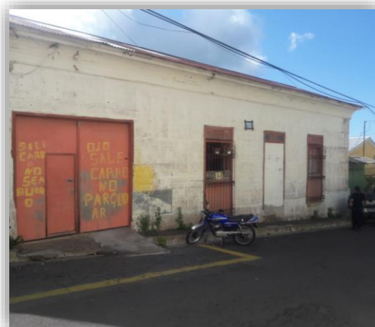
Imagen 19. Inmueble en Deterioro
