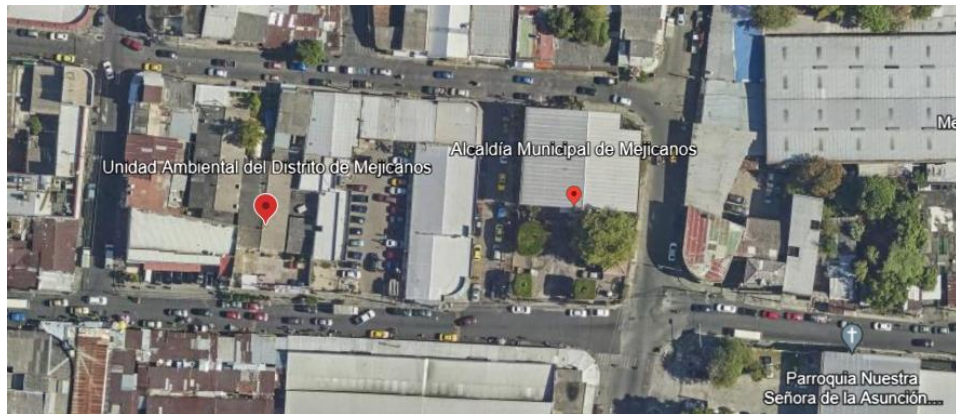
Figura 1. Ubicación geográfica de las oficinas de la Unidad Ambiental del Distrito de Mejicanos
