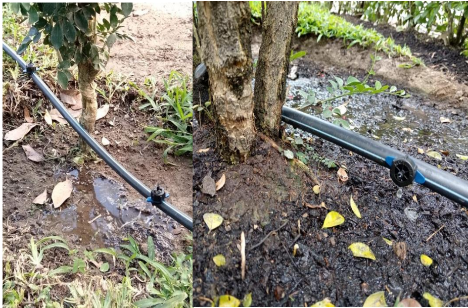
Anexo 10: Verificación de funcionamiento de goteros.
