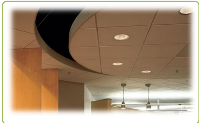
Imagen 50. Cielo Falso de Yeso. Fuente: www.warmstrong.com
