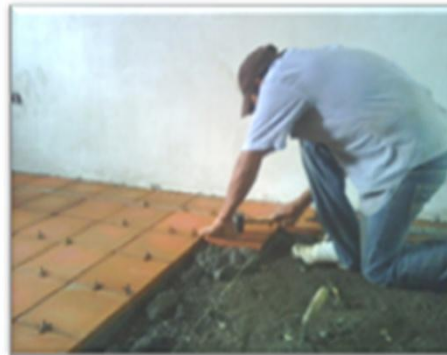
Colocación de Ladrillos
