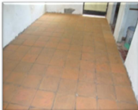
Piso después de Lijado para emparejar
