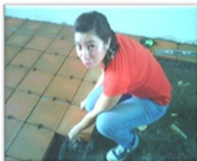
Colocación y Nivelación
