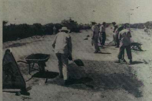
REPARAN VIA LITORAL. Usulután. Cuadrillas de trabajadores de Caminos realizan aceleradamente trabajos de reparación de la carretera del Litoral, en el tramo que conduce a San Marcos Lempa.
