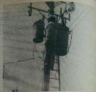
ALUMBRADO PUBLICO. El Refugio, Ahuachapán. Trabajadores de la CEL instalan lámparas de mercurio para el alumbrado publico en esta localidad, las cuales fueron proporcionadas por la municipalidad que preside Arturo Cazán.
