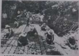
ADOQUINADO MIXTO. Entusiastamente, la comunidad del Barrio San José, Jr El Divisadero, construye su adoquinado mixto, que pronto estará terminado.
