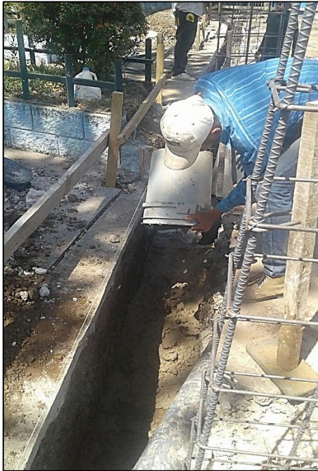
Imagen 3.2.2 (3): Desarrollo de la actividad colado de solera.
