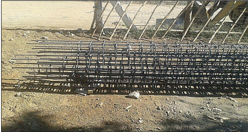
Imagen 3.2.3 (1): Soleras de fundación armadas.
