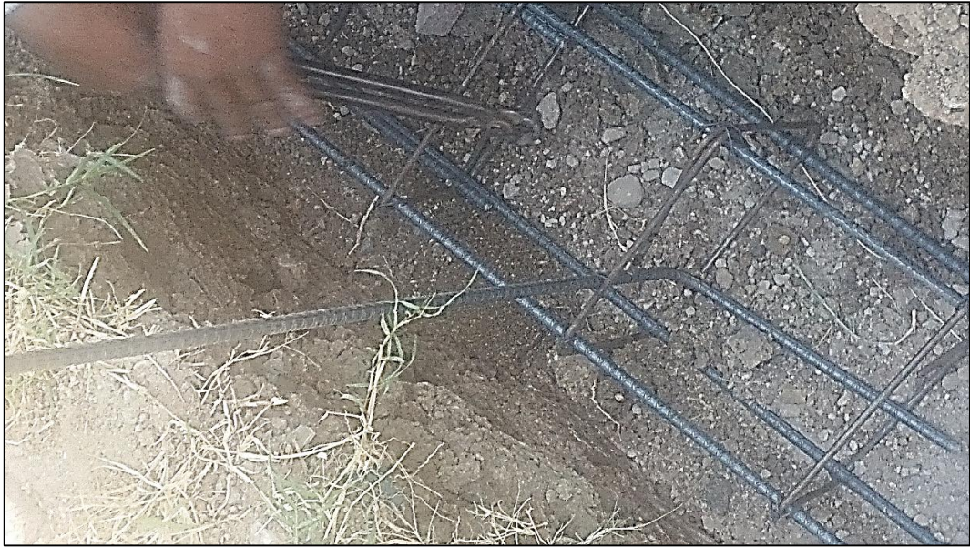
Imagen 3.2.1 (1): Armadura de la solera de fundación.
