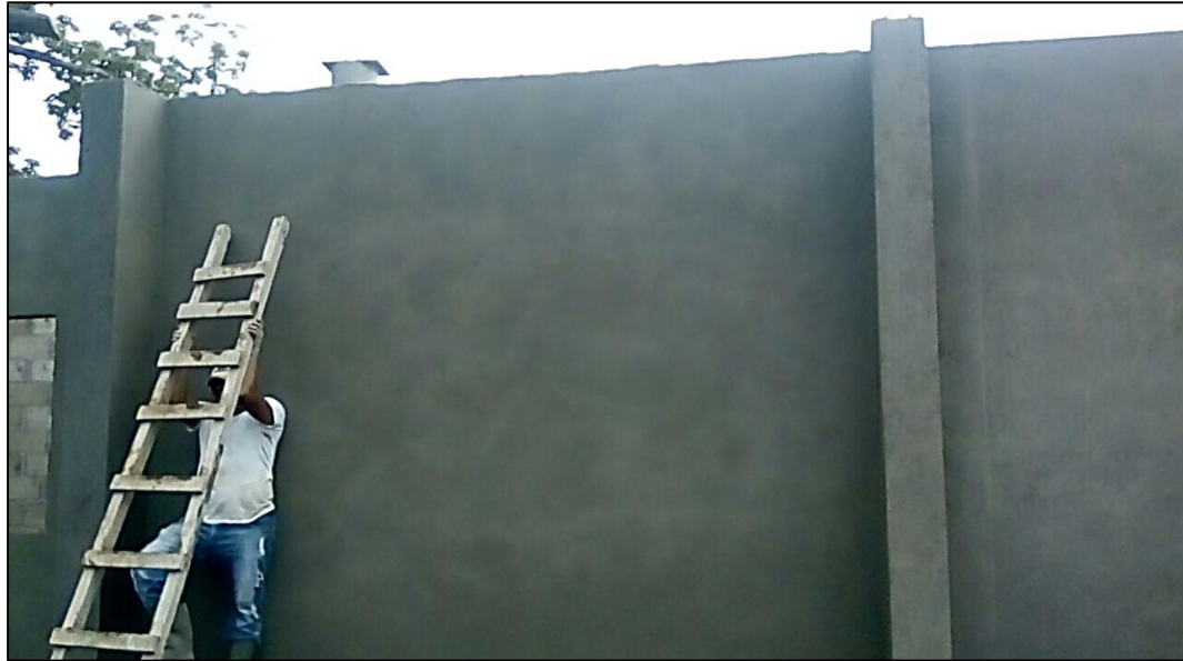
Imagen 3.2.1 (7): Desarrollo de la actividad de repello de paredes.
