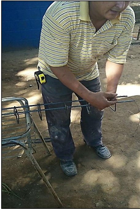
Imagen 3.2.2 (1): Desarrollo de la actividad Armadura de solera.
