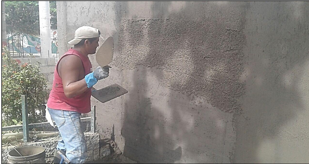
Imagen 3.2.3 (7): Desarrollo de la actividad de repello de paredes.
