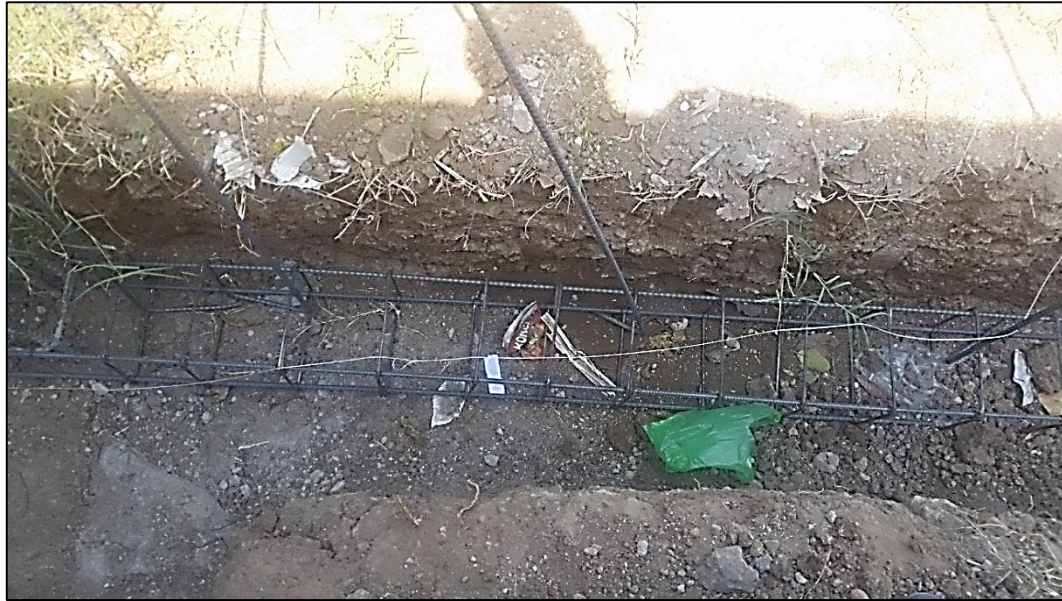
Imagen 3.2.1 (2): Espacio de la solera la cual se dispone a encofrar.
