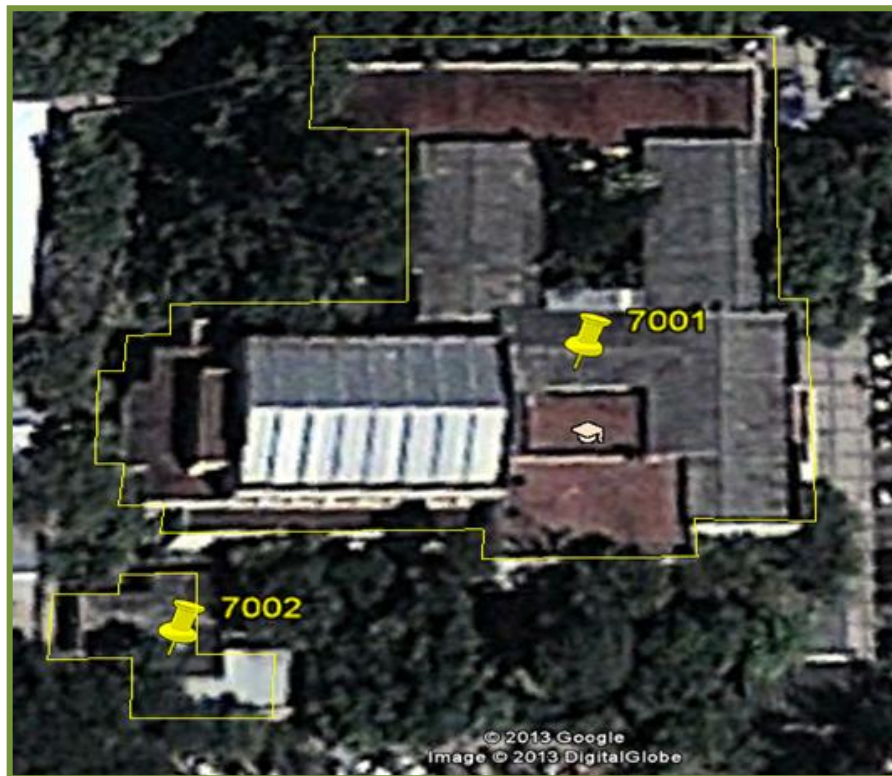
Figura 3. 8. Edificaciones de la Facultad de Jurisprudencia y Ciencias Sociales.
