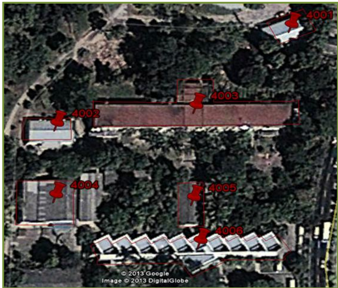
Figura 3. 5. Edificaciones de la Facultad de Ciencias Agronómicas. Fuente: Google
