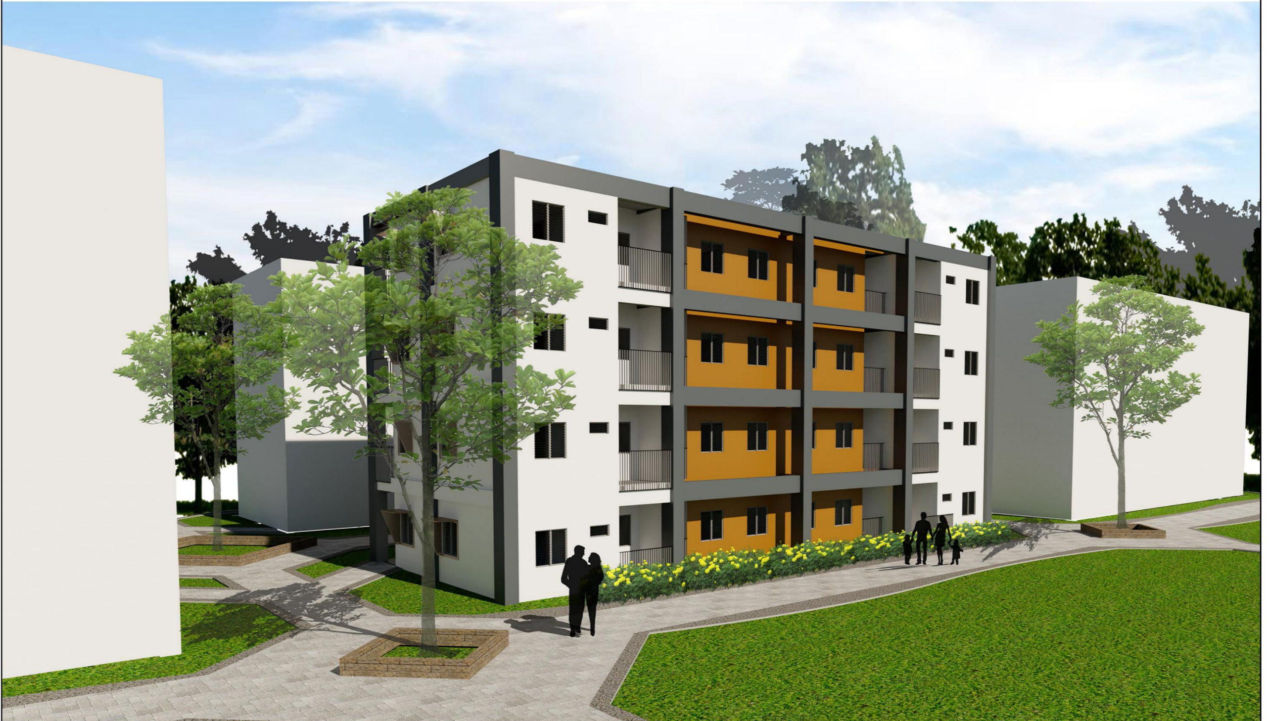
VISTA DE FACHADA PRINCIPAL DE EDIFICIO TIPO DE VIVIENDA
