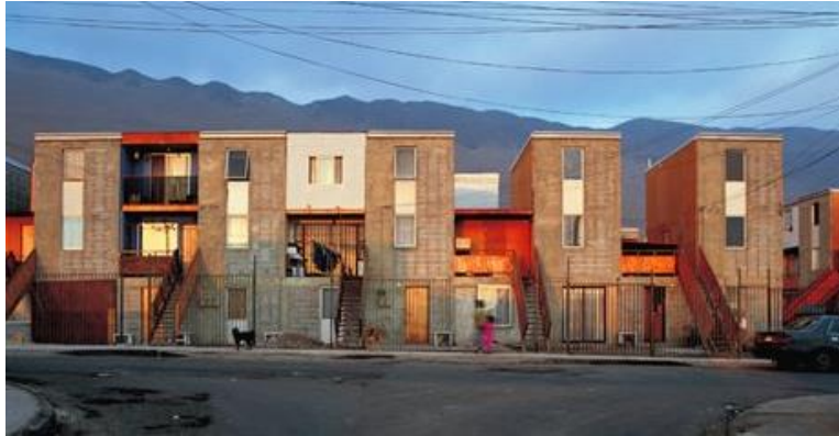
Fotografía EC-5: Viviendas ampliadas en Quinta Monroy. Fuente: Gooogle.com
