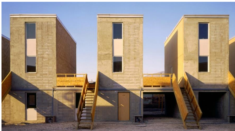
Fotografía EC-4: Proyecto Quinta Monroy, Iquique, Chile. Fuente: Plataforma de Arquitectura.
