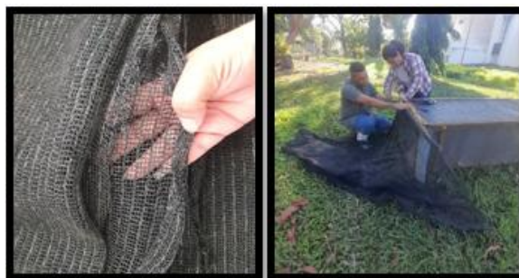
Figura 7. Colocación de cubierta malla sombra en el módulo de secado.
