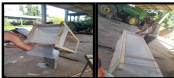
Figura 6. Colocación de película plástica UV en el módulo de secado.
