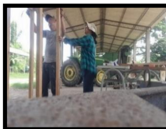
Figura 3. Cortes de madera para las puertas, techado del módulo de secado.
