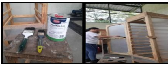
Figura 8. Aplicación de Comejenol Plus en el módulo de secado.
