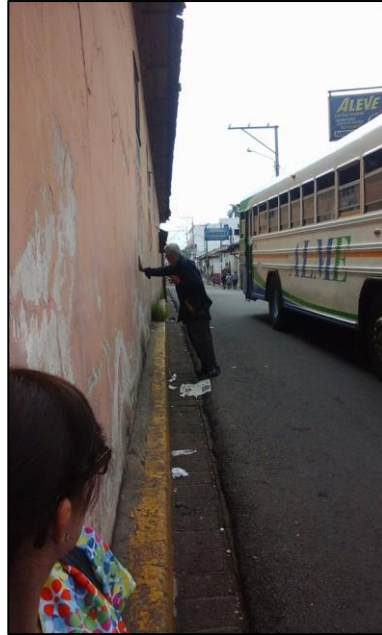
Las aceras que conduce a la entrada del portón de emergencia, no cumplen con el ancho mínimo.
