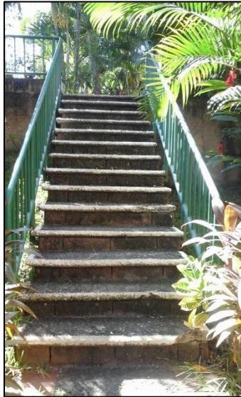
Gradas que conducen de Jardín a Biblioteca: los bordes de estas gradas son demasiado grandes y algunos escalones se encuentran en mal estado.
