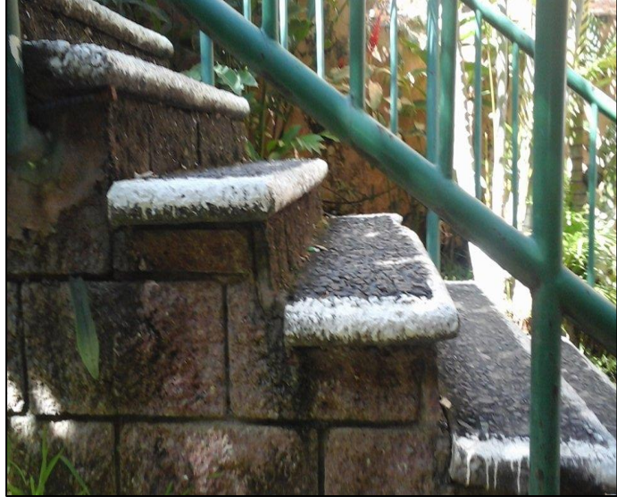
Gradas que conducen de Jardín a Biblioteca: los bordes de estas gradas son demasiado grandes y algunos escalones se encuentran en mal estado.
