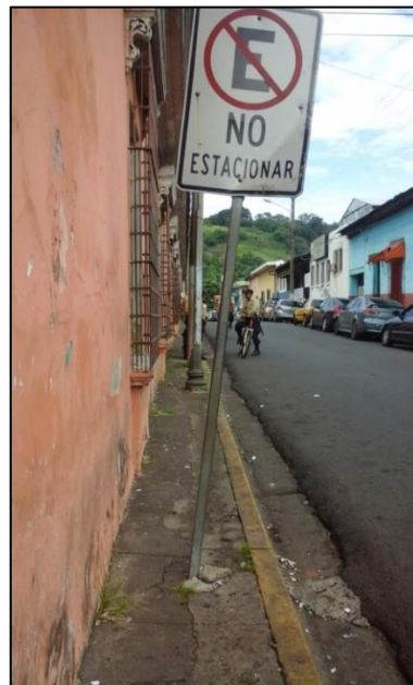
Las aceras que conduce a la entrada del portón de emergencia, no cumplen con el ancho mínimo.
