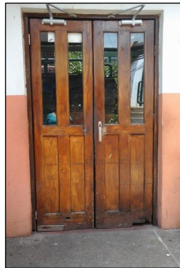
Entrada Cirugía Pediatría es de las pocas que cuentan con sistema de apertura hacia afuera.
