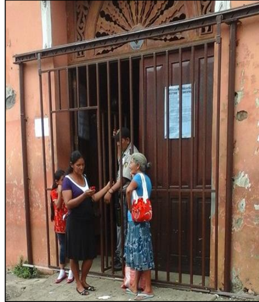
Entrada Principal. Puede observarse que no cuenta con las condiciones necesarias para ser utilizada por los usuarios
