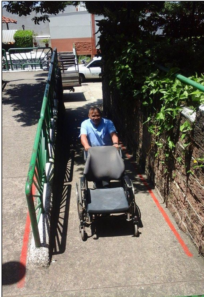
Rampa de acceso de cafetería a estacionamiento, regularmente utilizada por personal de servicios generales, se observo con una elevada pendiente.
