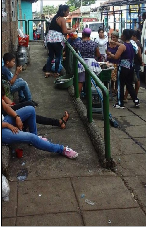
Rampa de Consulta externa se encuentra obstruida por vendedores del lugar.
