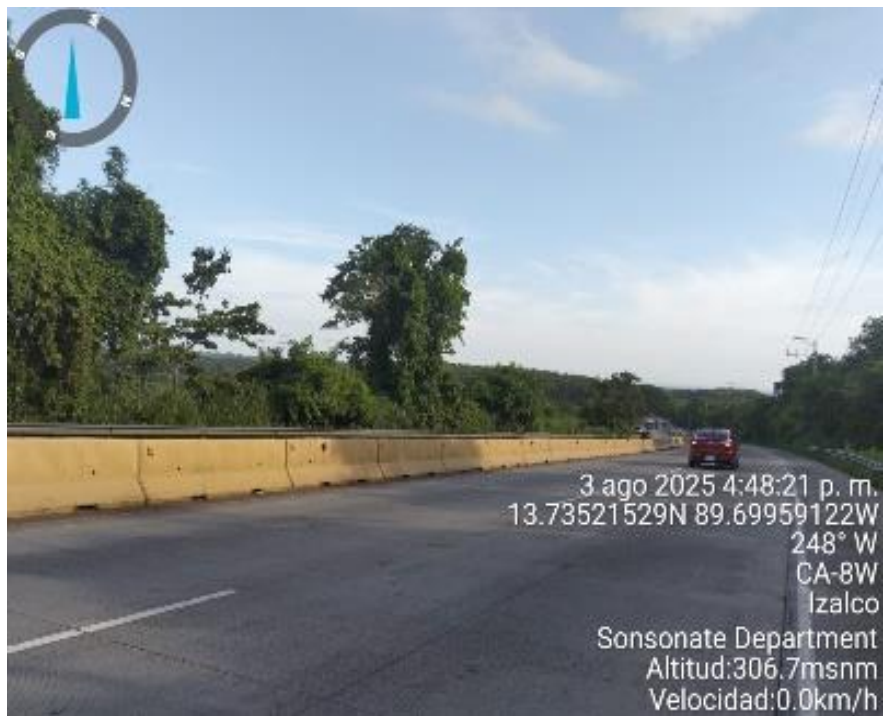
Anexo 0.29 CA-12, Fuente: Propia.
