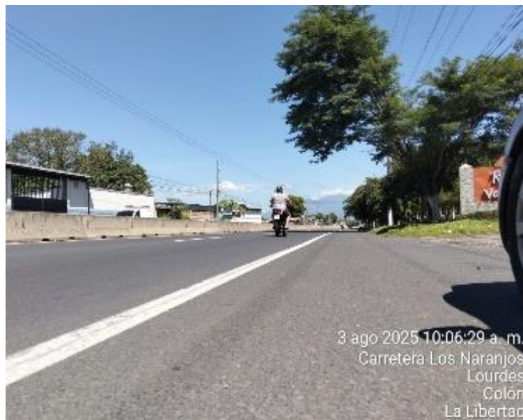
Anexo 0.41 CA-8, Fuente: Propia.
