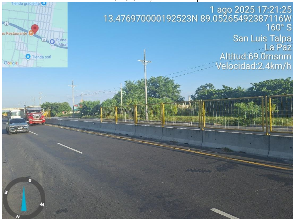
Anexo 0.14 CA-2, Fuente: Propia.
