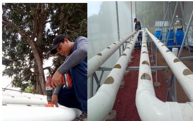
Figura 10. Tubos de producción para la colocación de plantas en modelo horizontal.
