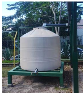
Figura 30. Colocación de tanque y canales para cosecha de agua.
