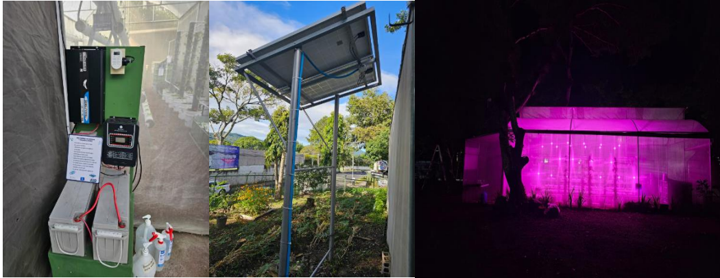
Figura 29. Instalación de sistema fotovoltaico y de luces led para la inducción de crecimiento de las hortalizas.
