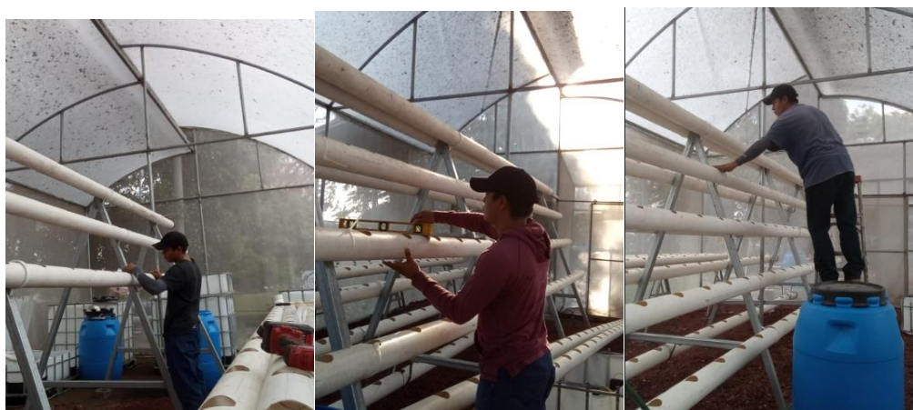
Figura 11. Montaje de tubos de producción para modelo vertical tipo “A”.
