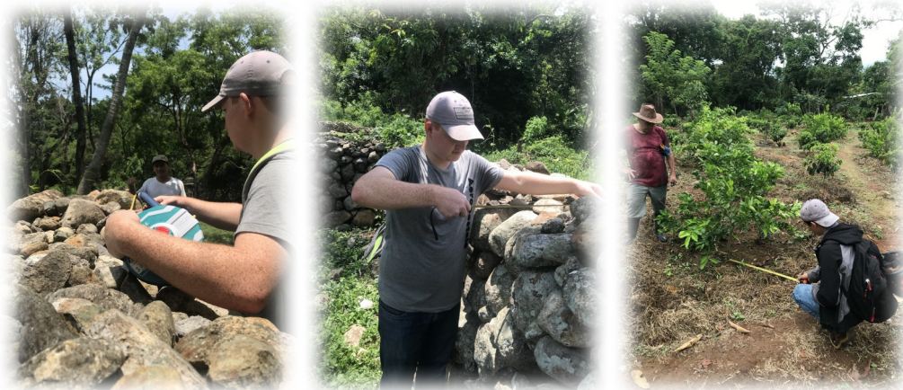
Figura 24. Supervisión y medición de obras realizadas por productores(as) del cantón El Carmen, San Ignacio.
