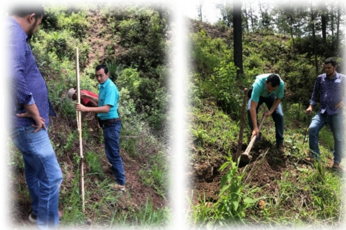
Figura 18. Demostración sobre trazo de curvas a nivel para construcción de acequias de ladera tipo trinchera a productores del cantón Lagunetas, Citalá.
