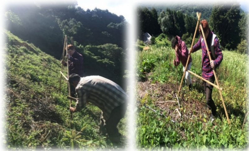
Figura 20. Demostración y realización de trazos de curvas a nivel para construcción de acequias de ladera tipo trinchera a productores del cantón Río Chiquito, San Ignacio.
