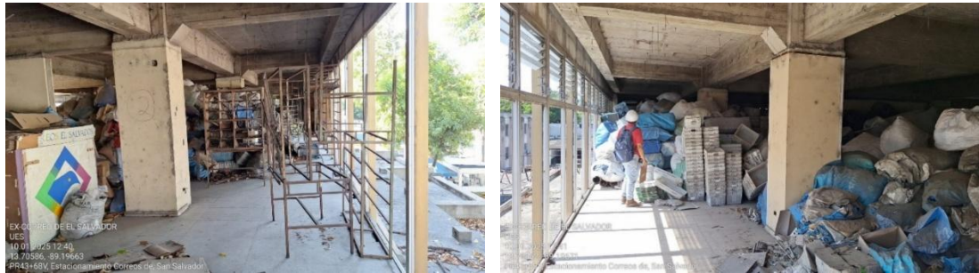
Imagen 1. Acceso restringido – segundo nivel. fuente: propia.
