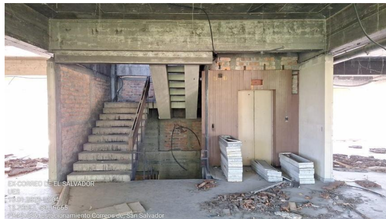
Imagen 48. Núcleo de escaleras y ascensor. fuente: propia
