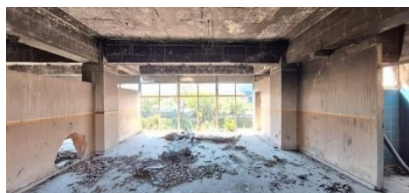
Imagen 36. Marco de concreto reforzado en sentido este - oeste fuente: propia
