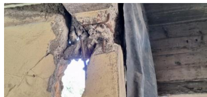
Imagen 50. Voladizo a los costados Este y Oeste, vinculación directa de las paredes de relleno con la estructura principal por medio de los nervios de confinamiento. fuente: propia
