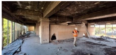
Imagen 35. Marco de concreto reforzado en sentido norte – sur fuente: propia
