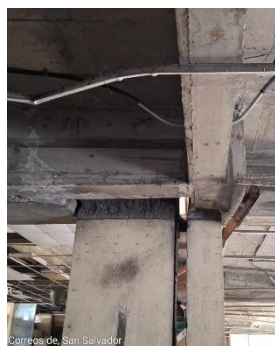
Imagen 37. Junta de dilatación de 10 cm entre ambos cuerpos del edificio fuente: propia
