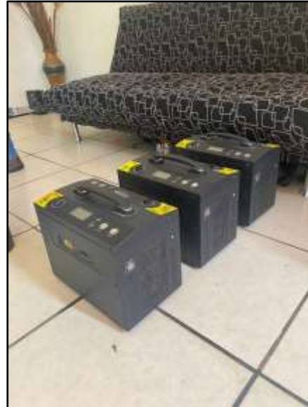
Imagen 5. Cuarto de bodega.
