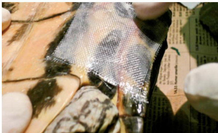
Figura 19: Colocación de fibra de vidrio sobre resina epoxi (Badia, X. Bueno, J.,2012).
