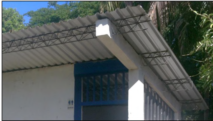
Imagen 3.62: Estructura de techo de servicios sanitarios. Fuente: Grupo de investigación.
