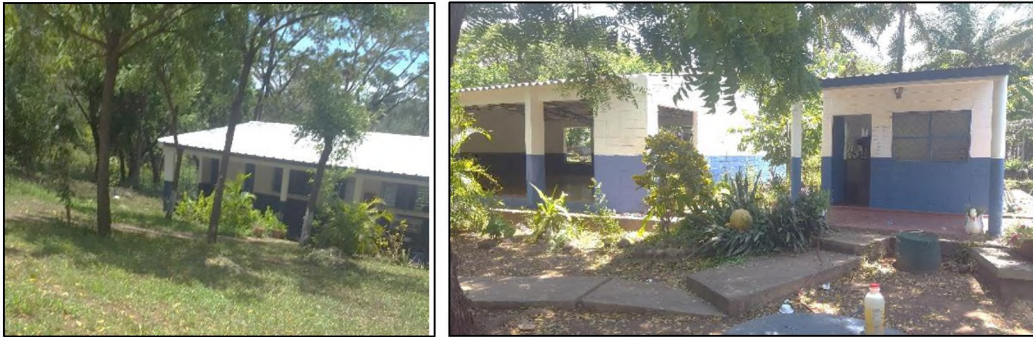
Imagen 3.136: Cubierta de fibrocemento y lámina galvanizada canal corriente. Fuente: Grupo de investigación.
