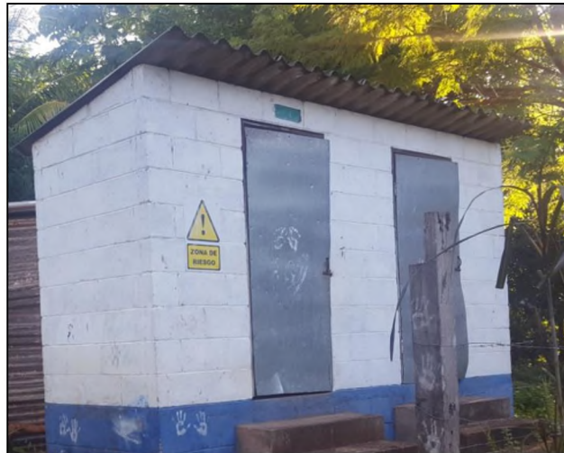
Imagen 3.93: Cubierta de lámina gris estándar de fibrocemento para los servicios sanitarios. Fuente: Grupo de investigación.
