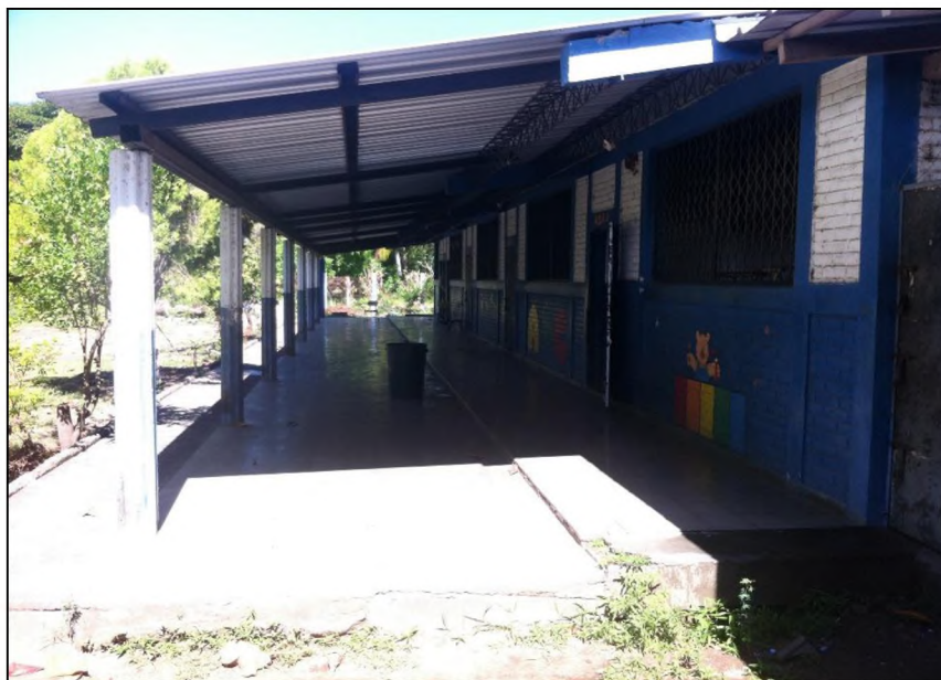
Imagen 3.19: Vista frontal del pabellón principal. Fuente: Grupo de investigación.
