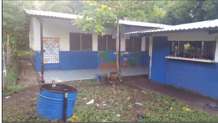
Imagen 3.92: Cubierta de módulos con lámina de aluminio acanalada. Fuente: Grupo de investigación.
