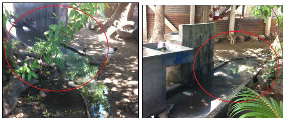
Imagen 3.7: Resumidero donde se captan aguas grises y pluviales. Fuente: Grupo de investigación.
