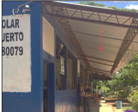
Imagen 3.60: Cubierta de lámina de aluminio en aulas. Fuente: Grupo de investigación.
