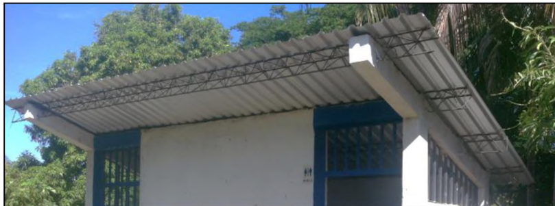
Imagen 3.61: Cubierta de lámina de aluminio en servicios sanitarios. Fuente: Grupo de investigación.
