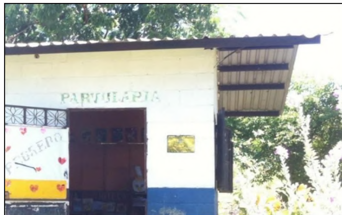
Imagen 3.108: Estructura de techo de aula independiente de módulo principal. Fuente: Grupo de investigación.
