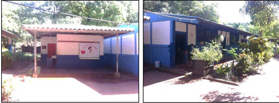
Imagen 3.150: Cubierta de fibrocemento y lámina galvanizada canal corriente. Fuente: Grupo de investigación.
