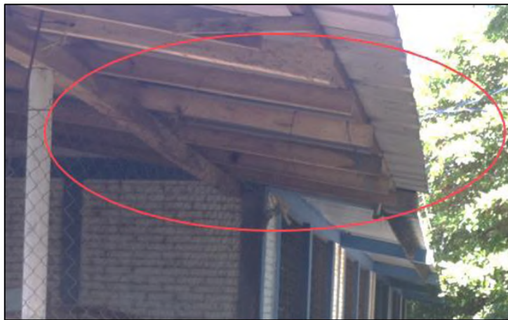
Imagen 3.31: Cubierta de lámina de aluminio acanalada sobre área de cocina y bodega. Fuente: Grupo de investigación.
