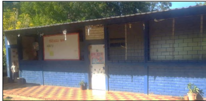
Imagen 3.77: Cubierta de lámina de aluminio acanalada en aulas. Fuente: Grupo de investigación.
