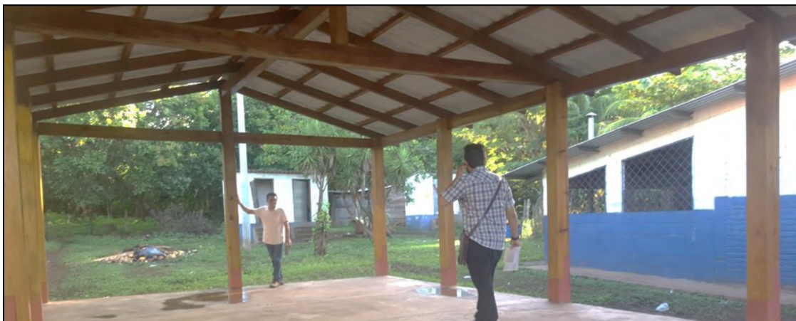
Imagen 3.95: Estructura de techo de área de reuniones. Fuente: Grupo de investigación.
