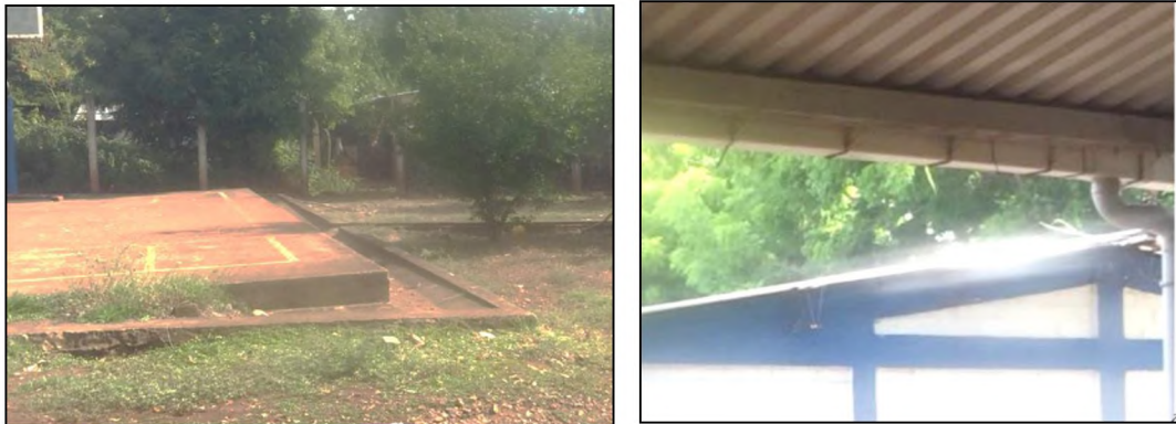
Imagen 3.38: Drenaje pluvial . Fuente: Grupo de investigación.
