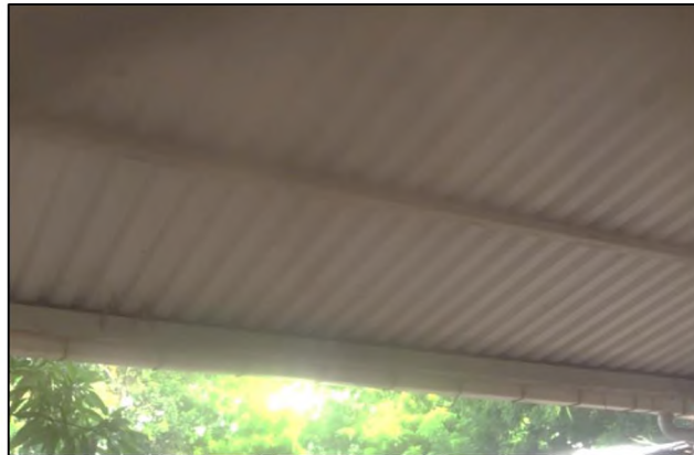
Imagen 3.47: Estructura de techo del área de reuniones. Fuente: Grupo de investigación.
