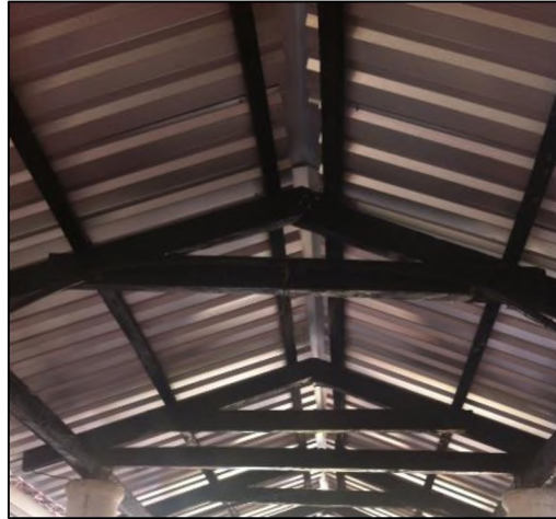
Imagen 3.18: Estructura de techo de madera . Fuente: Grupo de investigación.
