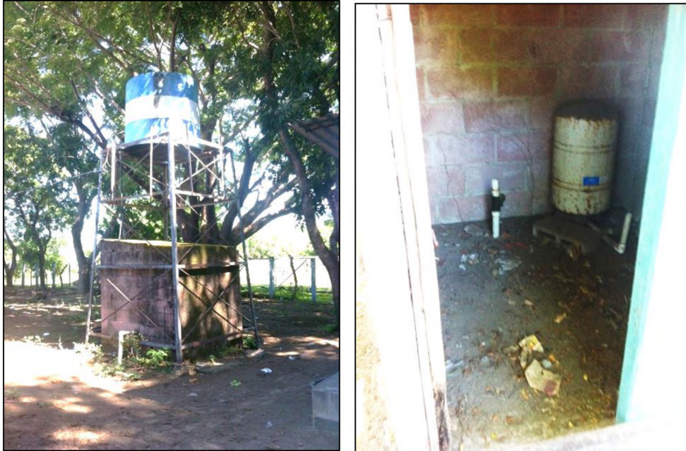
Imagen 3.22: Estado actual del tanque de almacenamiento y equipo de bombeo. Fuente: Grupo de investigación.
