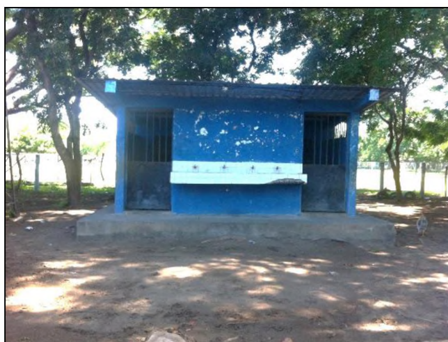
Imagen 3.24: Servicios sanitarios del centro escolar. Fuente: Grupo de investigación.
