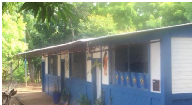
Imagen 3.48: Estructura de techo en las aulas en buen estado. Fuente: Grupo de investigación.
