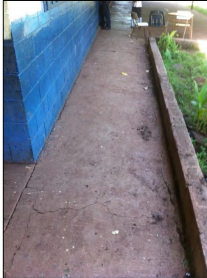
Imagen 3.100: Drenaje pluvial. Fuente: Grupo de investigación.
