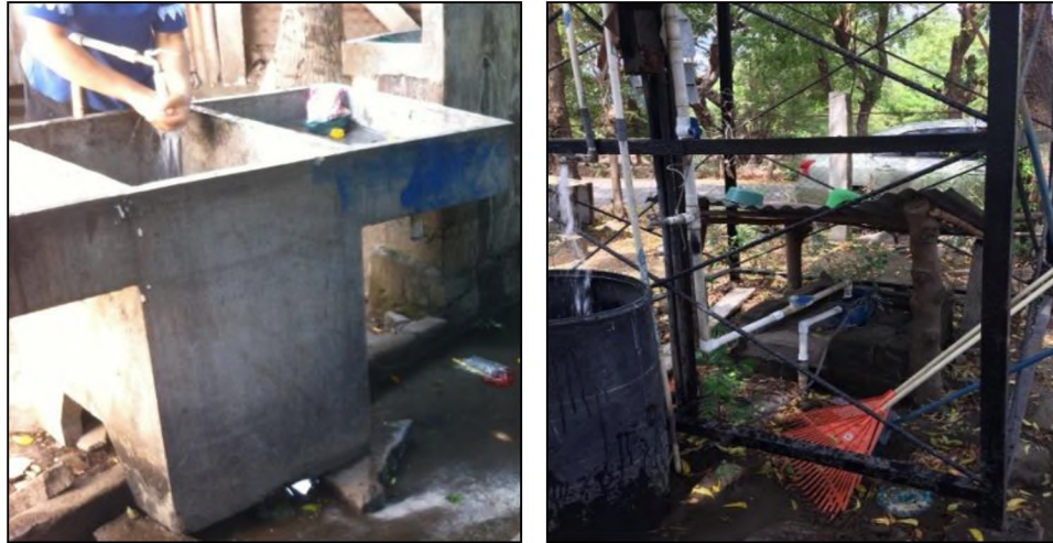
Imagen 3.5: Agua potable proporcionada por ADESCO y extracción de agua al pozo artesanal. Fuente: Grupo de investigación.
