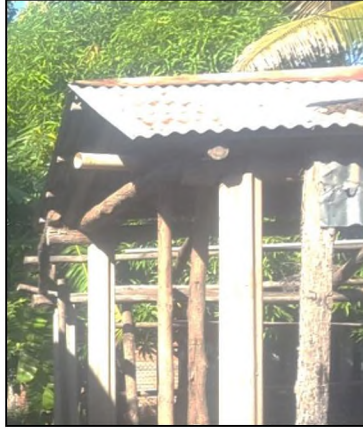
Imagen 3.76: Cubierta de lámina de aluminio de canal corriente en espacio para reuniones. Fuente: Grupo de investigación.
