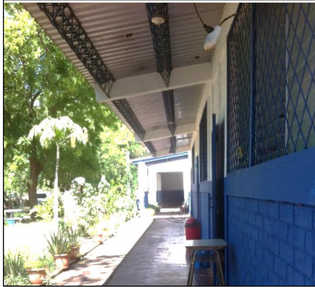
Imagen 3.138: Estructura de techo de lámina de aluminio y pólin espacial. Fuente: Grupo de investigación.
