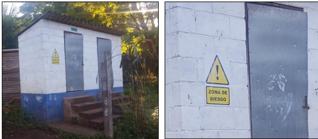
Imagen 3.86: Servicios sanitarios de hoyo seco clausurados. Fuente: Grupo de investigación.
