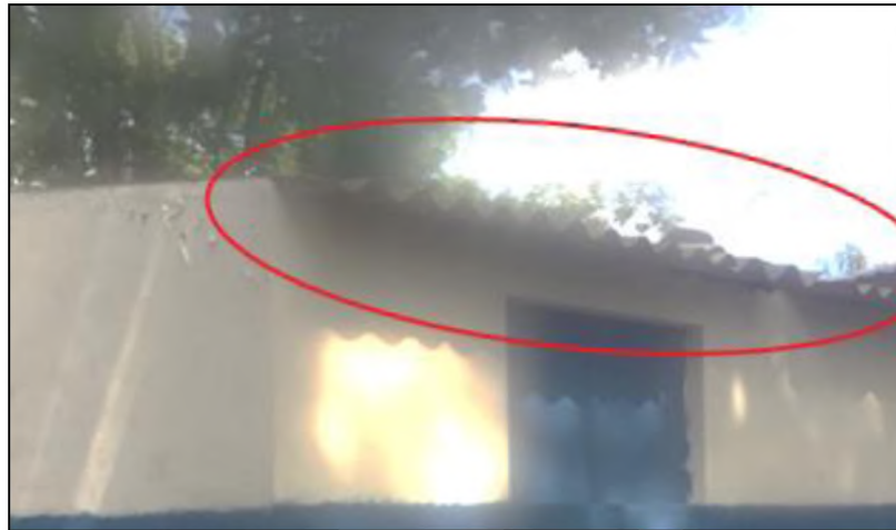
Imagen 3.46: Cubierta de lámina gris estándar de fibrocemento. Fuente: Grupo de investigación.
