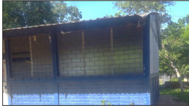
Imagen 3.78: Polín espacial en estructura de techo de las aulas. Fuente: Grupo de investigación.
