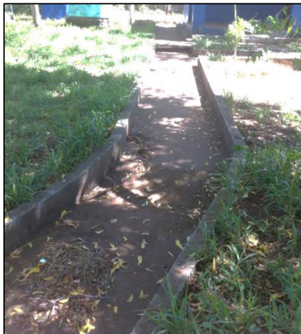
Imagen 3.128: Canal abierto para drenaje pluvial. Fuente: Grupo de investigación.
