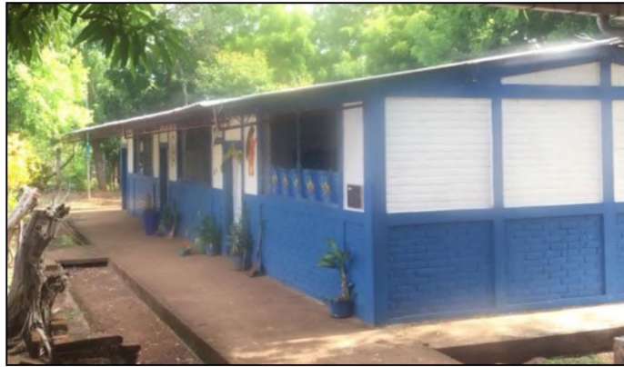
Imagen 3.45: Cubierta de techo de lámina de aluminio acanalada. Fuente: Grupo de investigación.
