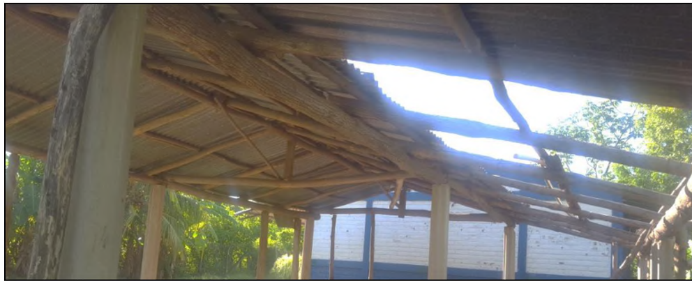
Imagen 3.79: Estructura de techo de madera. Fuente: Grupo de investigación.
