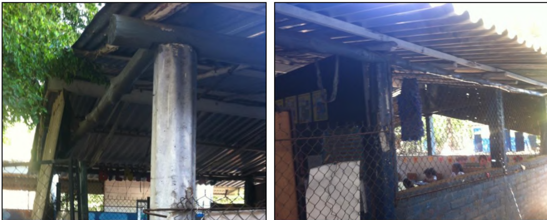
Imagen 3.17: Estructura de techo de las aulas más pequeñas. Fuente: Grupo de investigación.
